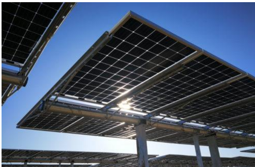
Figura 3.2: Esempio di struttura a tracker monoassiale
