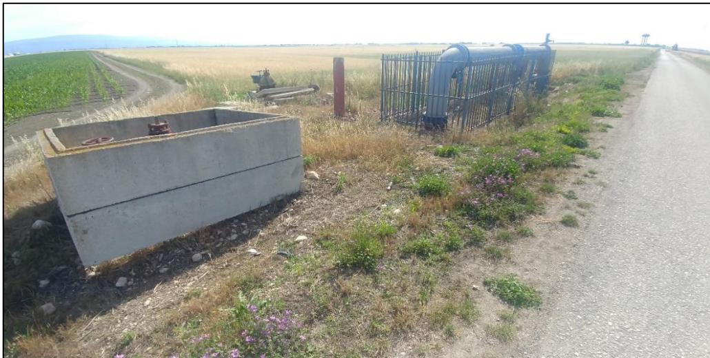
Immagine punto di rilievo 5 (condotta Consorzio di Bonifica)
