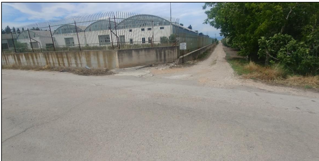
Immagine punto di rilievo 16 (accesso da complanare)
