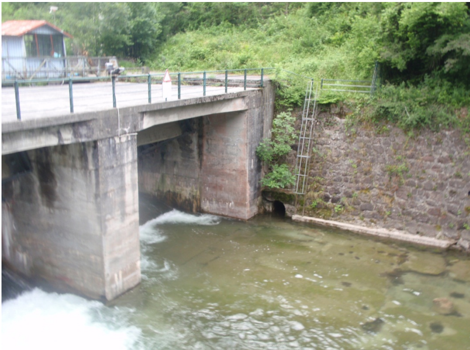
Figura 61: Traversa di sbarramento esistente vista da valle.
