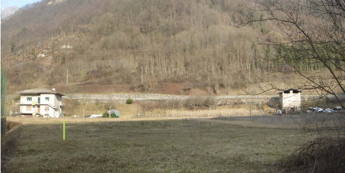
Figura 57 Area di sbocco della galleria.
