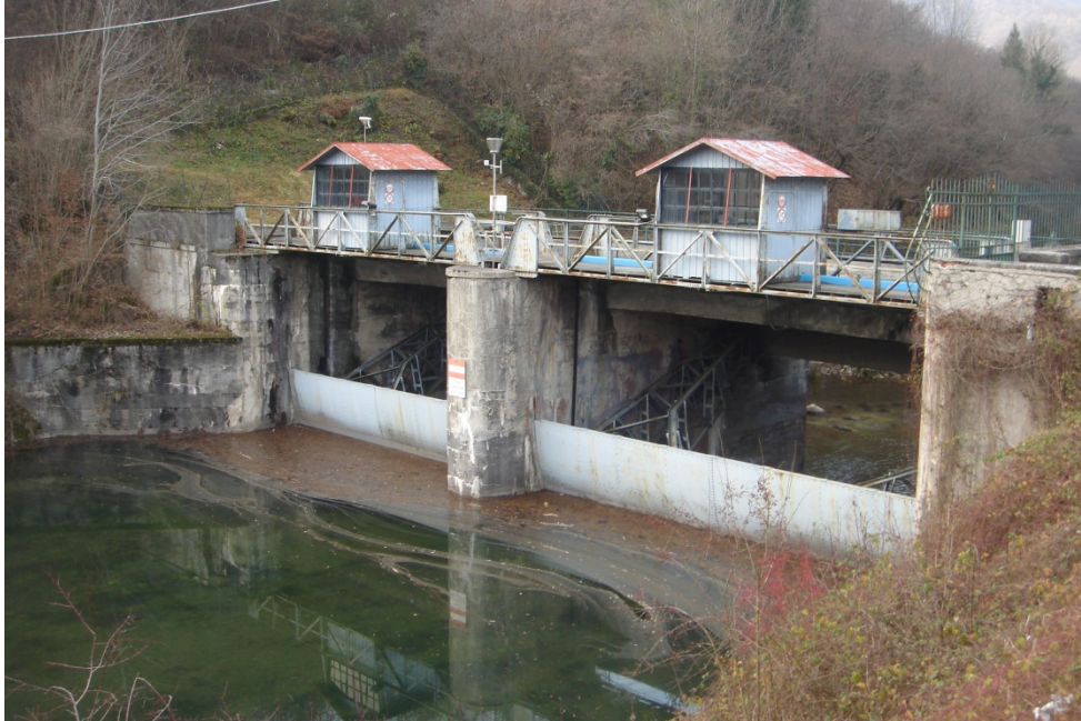
Figura 60: Traversa di sbarramento esistente vista da valle.
