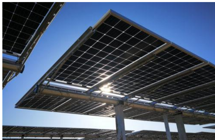
Figura 2.37: Esempio di struttura tipo tracker monoassiale
