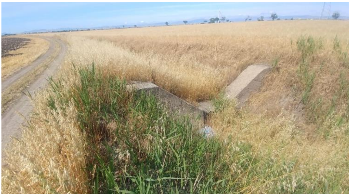
Figura 4.22: Zona di attraversamento del torrente Laccio
