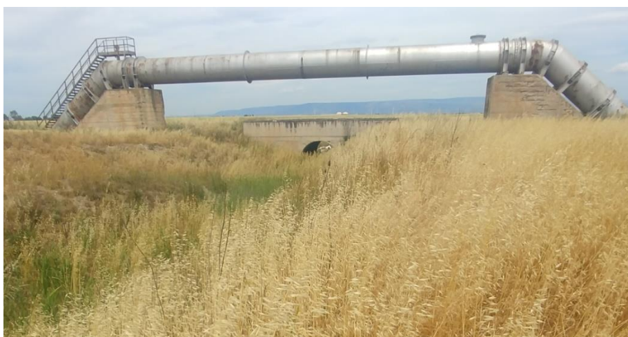
Figura 4.5: Torrente Laccio - perimetro nord-ovest del sito
