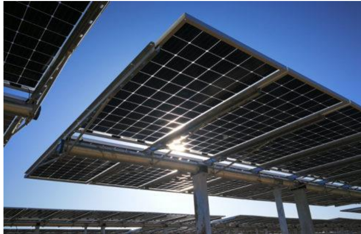
Figura 2.7: Esempio di struttura tipo tracker monoassiale
