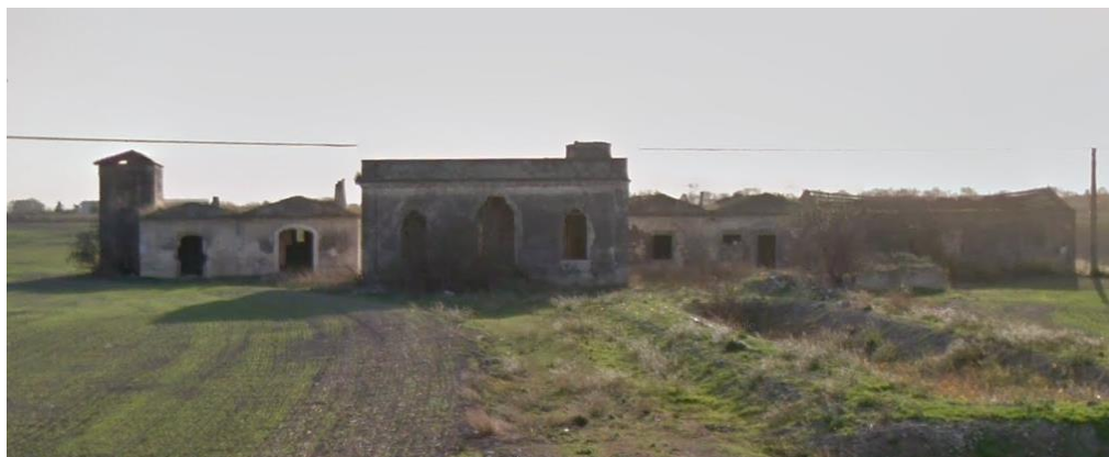
Figura 4.4: Masseria Mari nell’intorno del sito
