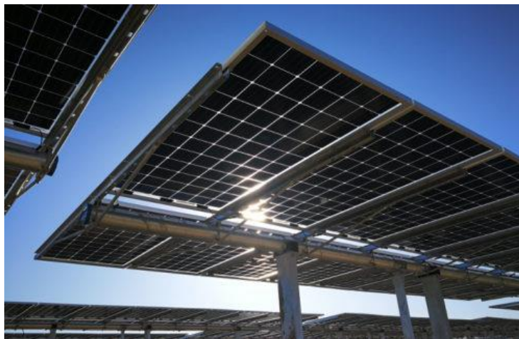
Figura 2.7: Esempio di struttura tipo tracker monoassiale
