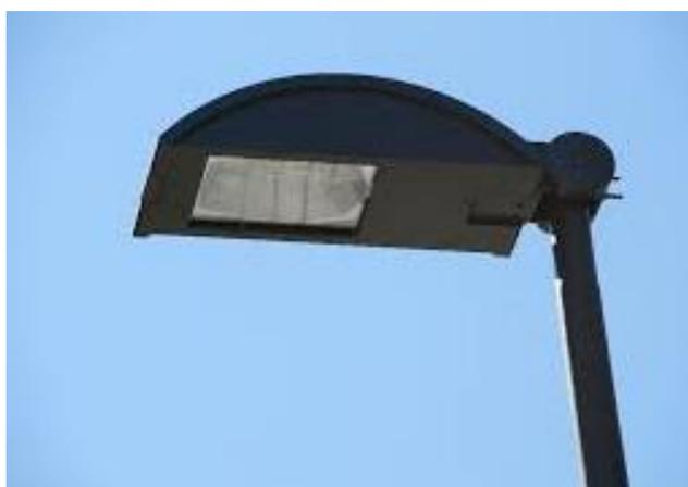
Figura 4.3: Esempio di apparecchio completamente schermato (full-cut-off).
