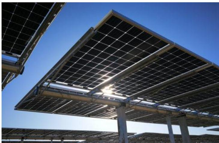
Figura 2.7: Esempio di struttura tipo tracker monoassiale
