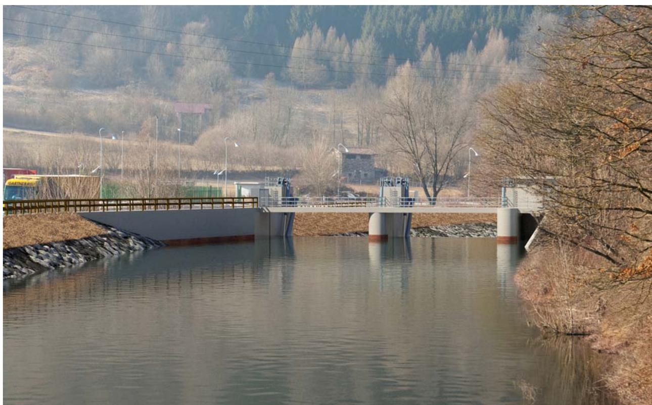
Figura 46: vista da monte della nuova traversa con livello alla massima regolazione di 368.00 m slm e raffronto con lo stato di fatto (sopra)
