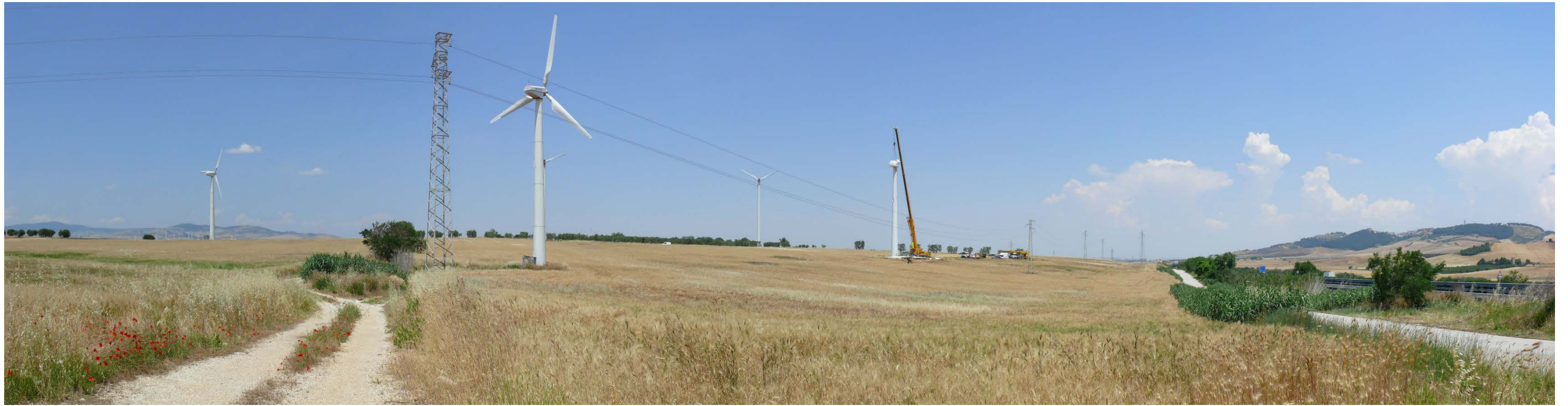
Stato di fatto – Punto di presa P6
