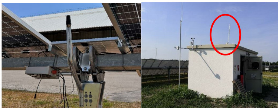
Esempio di collegamento - L'antenna TP sul tracker (a sinistra) e l'antenna del RP nella parte superiore della stazione di trasformazione (a destra)
