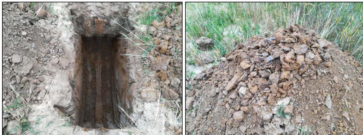
Foto 2: fase di realizzazione del pozzetto geognostico P1 (a sinistra) e materiale estratto (a destra).
