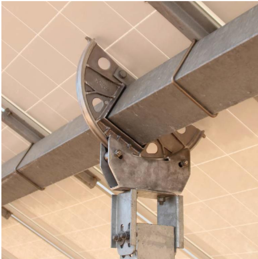
Schema nodo trave-pilastrino
