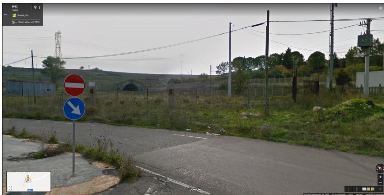
Figura 5-14 Imbocco della "Galleria Madonna del Carmine" in direzione Taranto – km 67+936
