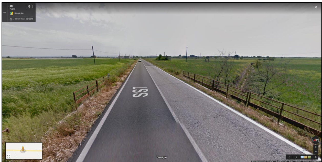
Figura 5-5 Corso d'acqua episodico n. 1 dell'AdB - km 609+335 della SS7
