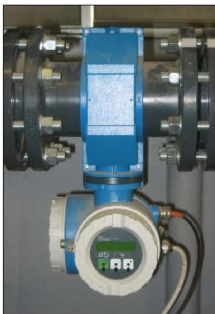
Figura C.2. Trasduttore di portata elettromagnetico.
