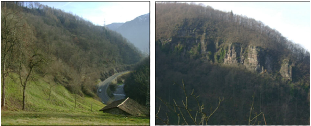
Figura 2.1 – Particolare di terrazzi stabili e orli di scarpata rocciosa nel tratto di versante interessato dalla realizzazione della galleria in progetto.
