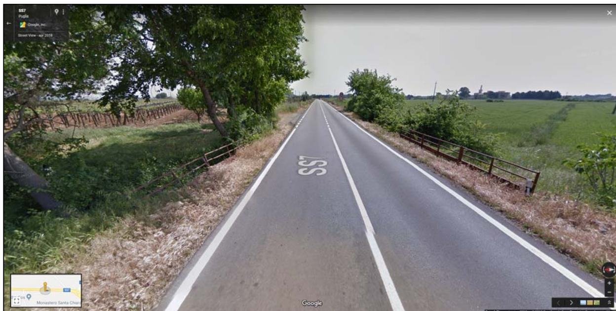
Figura 49- Canale da CTR n. 3 - km 611+631 della SS7
