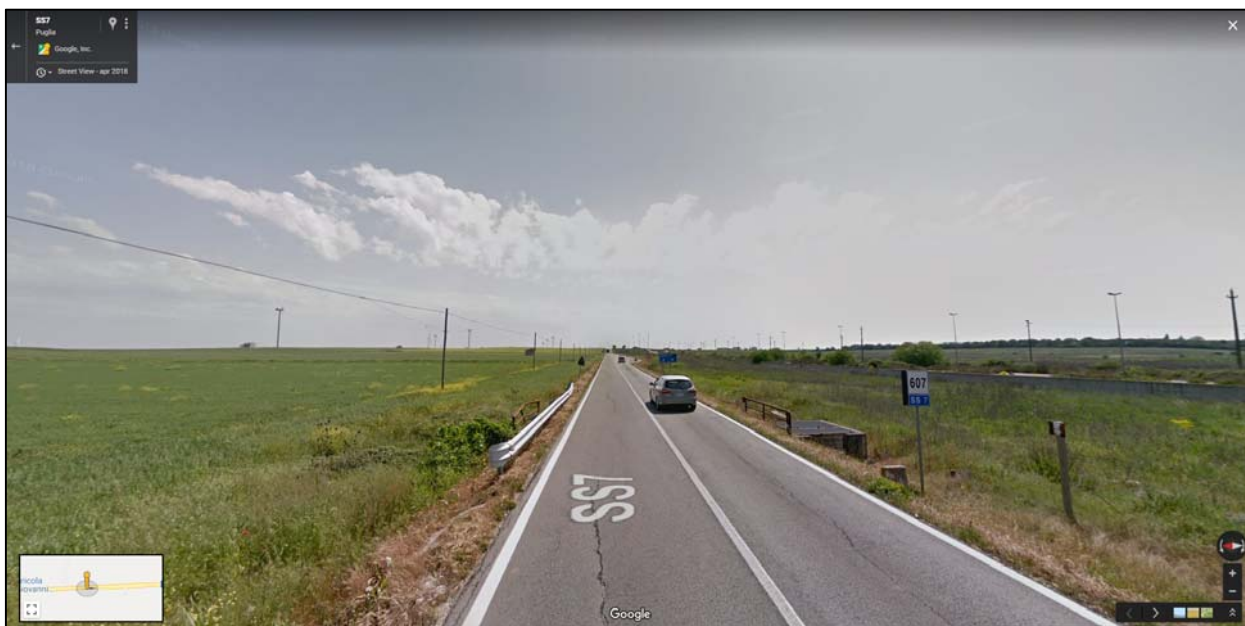
Figura 45- Canale da CTR n. 1 - km 607+006 della SS7
