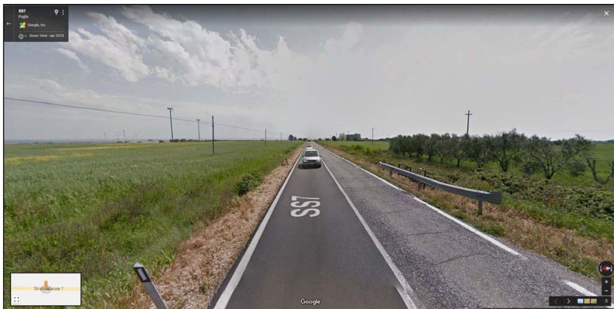
Figura 46- Canale da CTR n. 2 - km 608+547 della SS7
