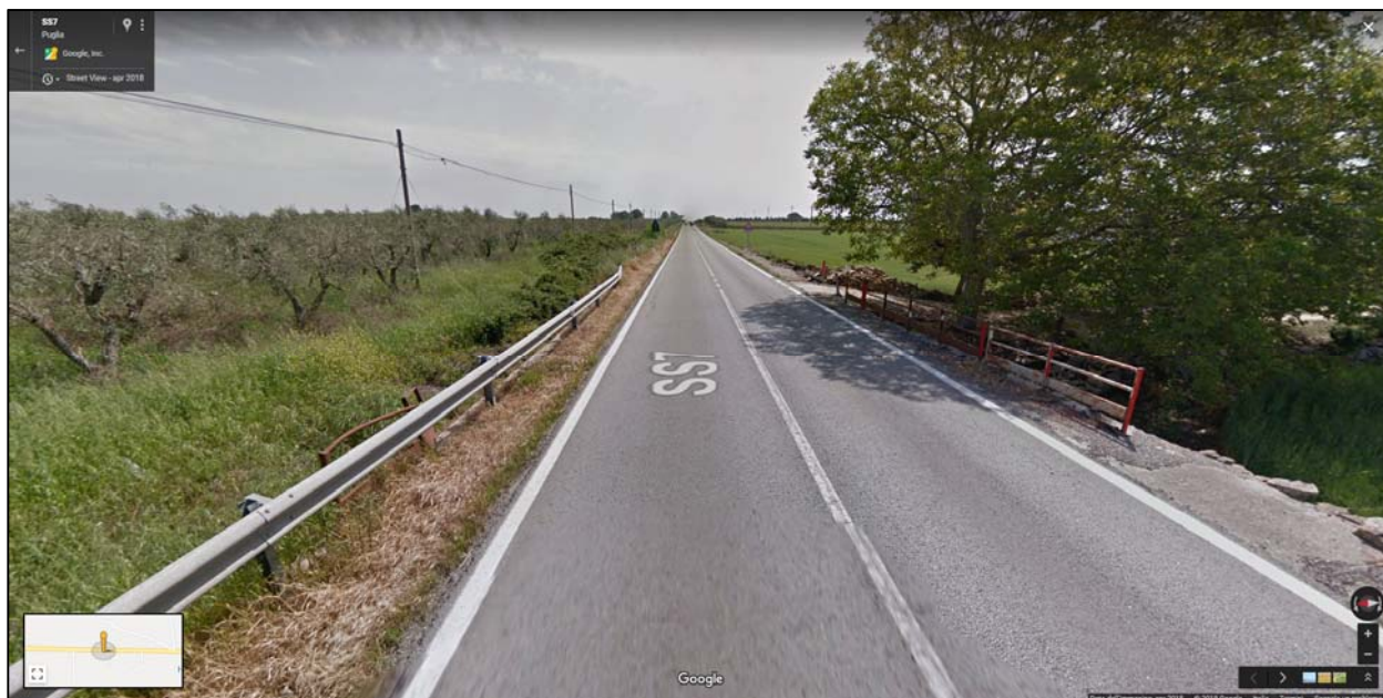
Figura 48- Corso d'acqua episodico n. 2 dell'AdB - km 610+565 della SS7
