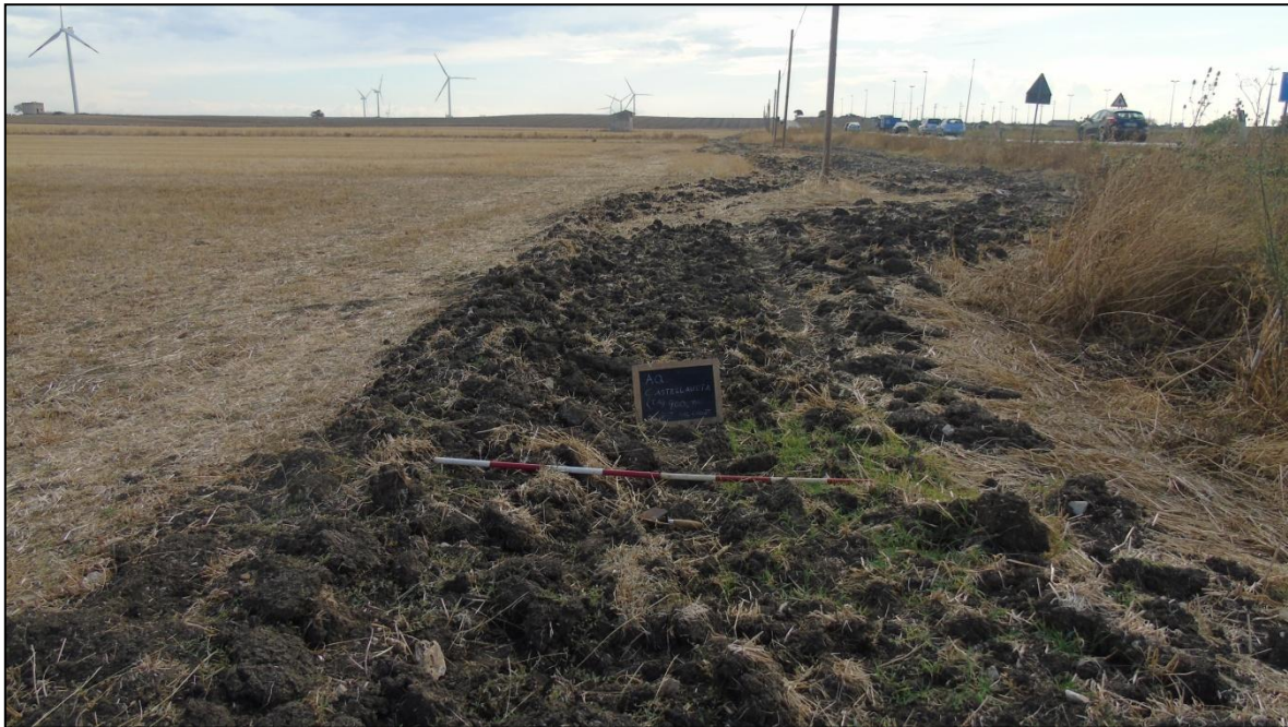
Fig. 15. Castellaneta (TA). "Progetto per la realizzazione della rete idrica dell'abitato di Castellaneta e potenziamento del serbatoio". Suburbana di progetto. Al ciglio della strada è stata praticata un'aratura taglia fuoco, a protezione da eventuali incendi.
