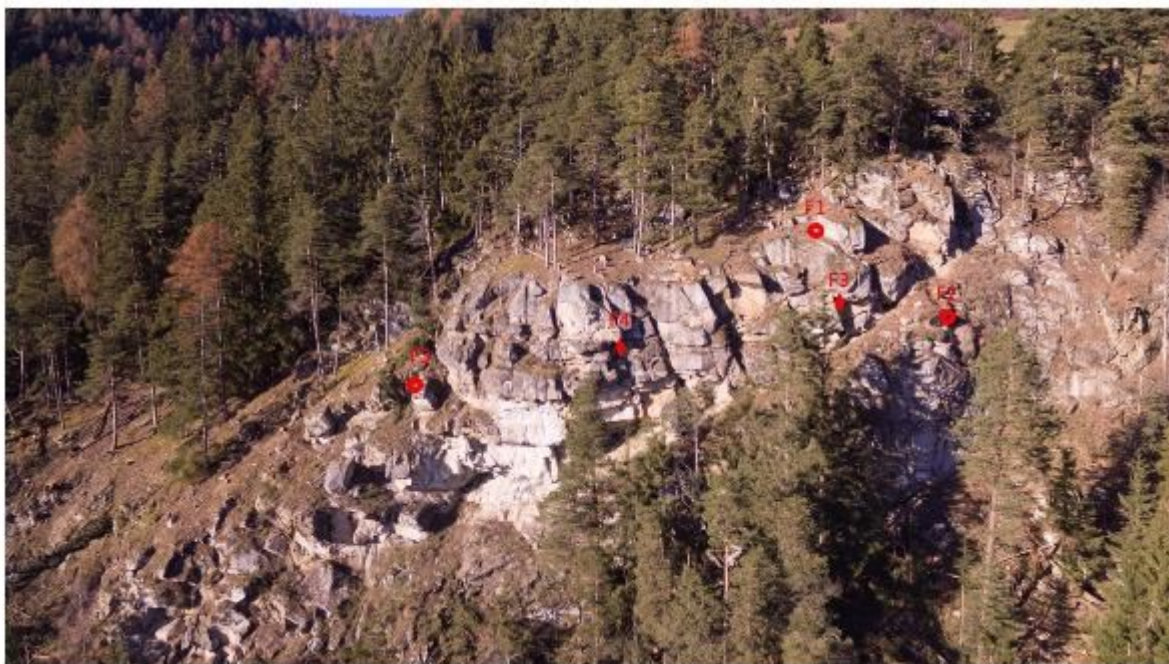
Fig. 1. L'ammasso roccioso sovrastante la linea ferroviaria della Val Pusteria sede del distacco di alcuni blocchi nel novembre 2019. I simboli in rosso indicano l'ubicazione degli strumenti installati (cerchio per estensimetri a barra e rombi per estensimetri a filo).
