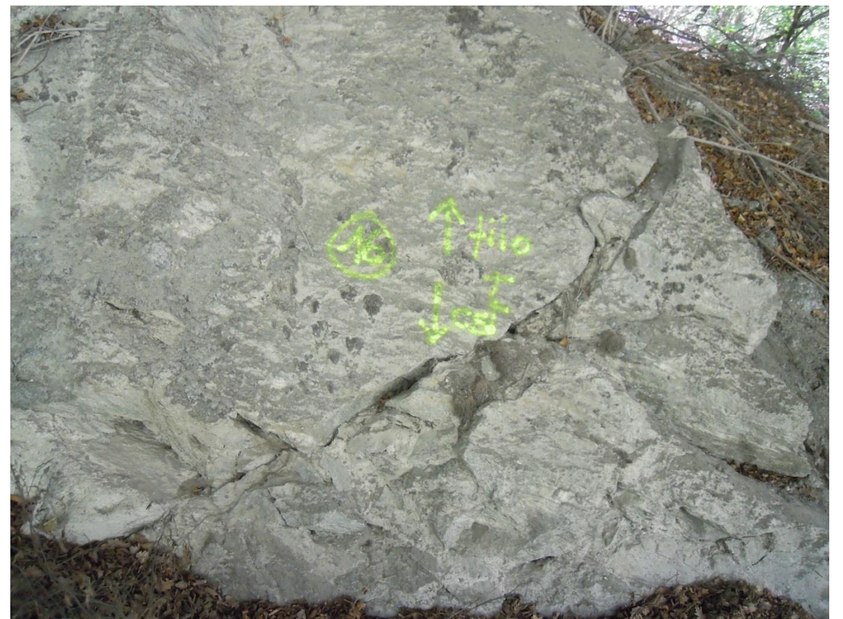
Posizioni 16 e 17. Dettaglio
