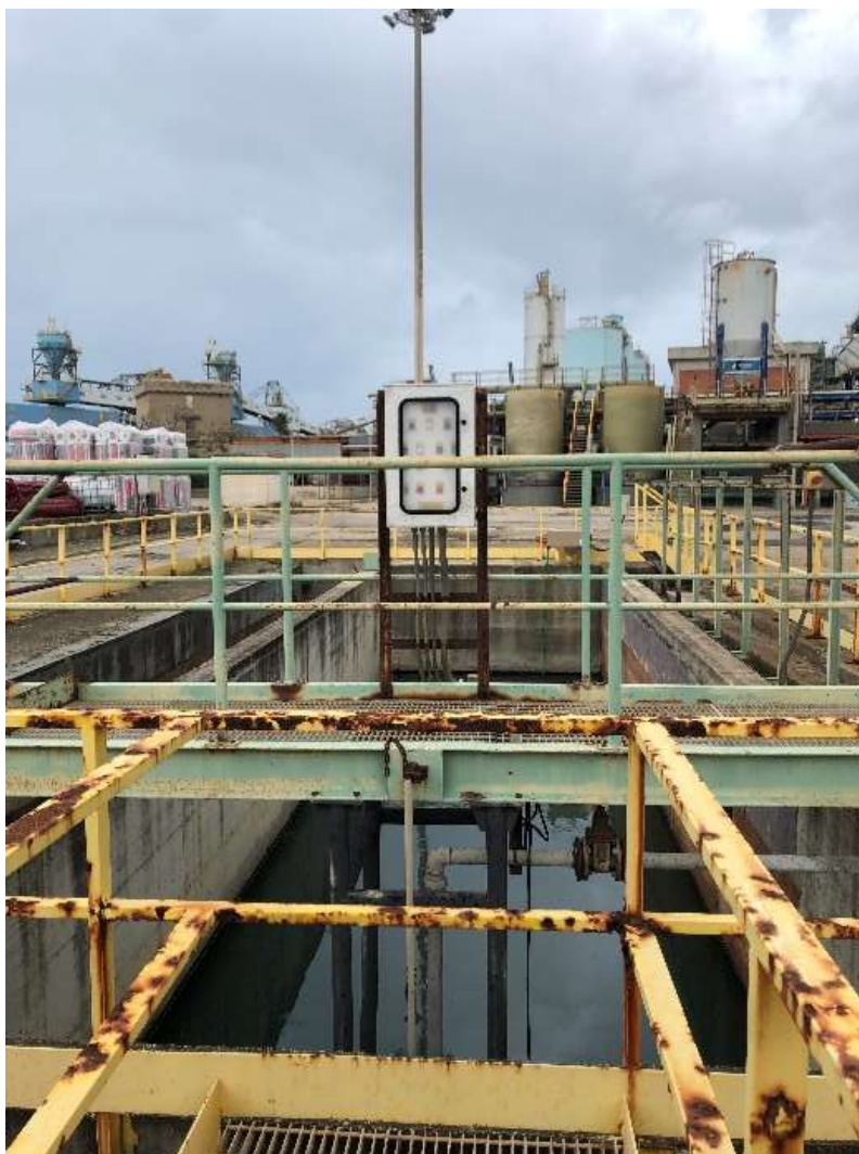
Figura 4 – Vasca di prima pioggia delle acque meteoriche.
