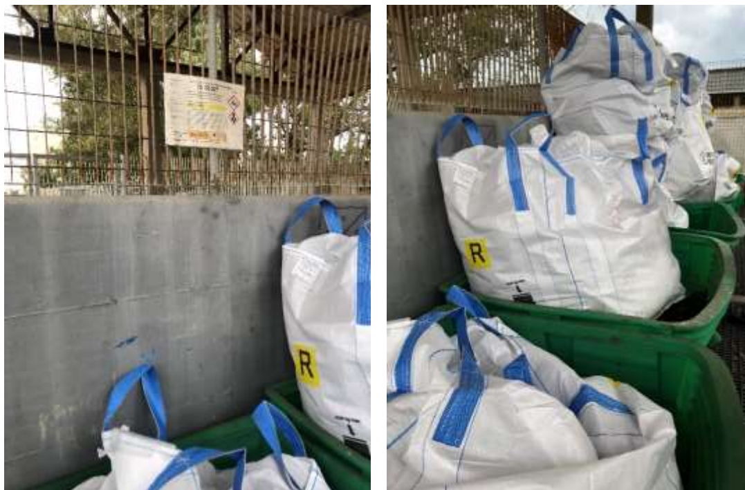
Figura 8 – Big bags contenenti rifiuti assorbenti, materiali filtranti (inclusi filtri dell'olio non specificati altrimenti), stracci e indumenti protettivi, contaminati da sostanze pericolose (CER 150202*).
