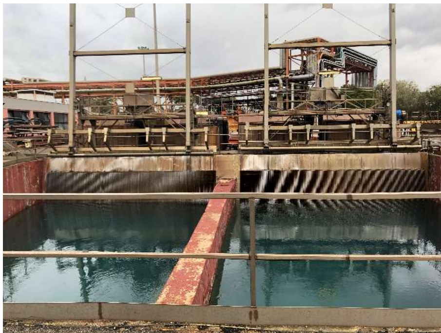
Figura 5 – N°2 unità di grigliatura poste in parallelo.
