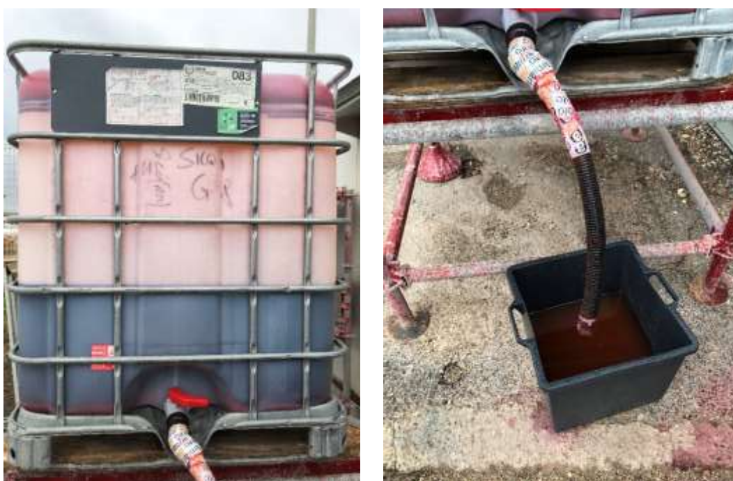
Figura 9 – Serbatoio contenente incapsulante per la bonifica di materiali contenenti amianto.
