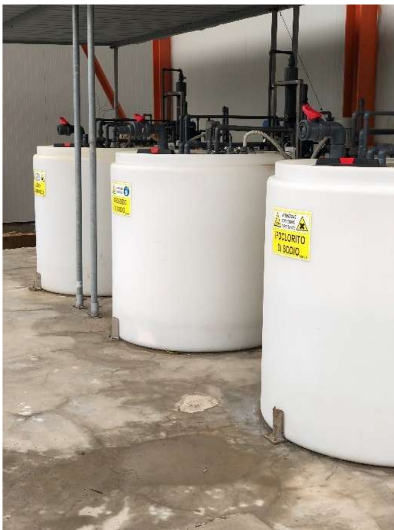
Figura 2 - Nuovi serbatoi di stoccaggio chemicals .
