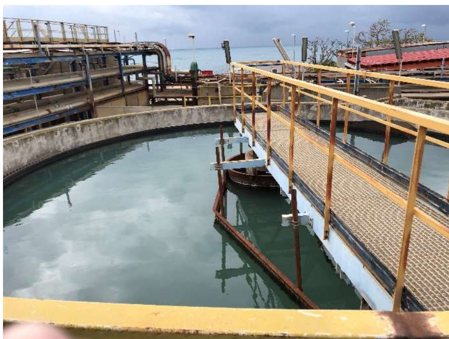
Figura 6 – Sedimentatore.
