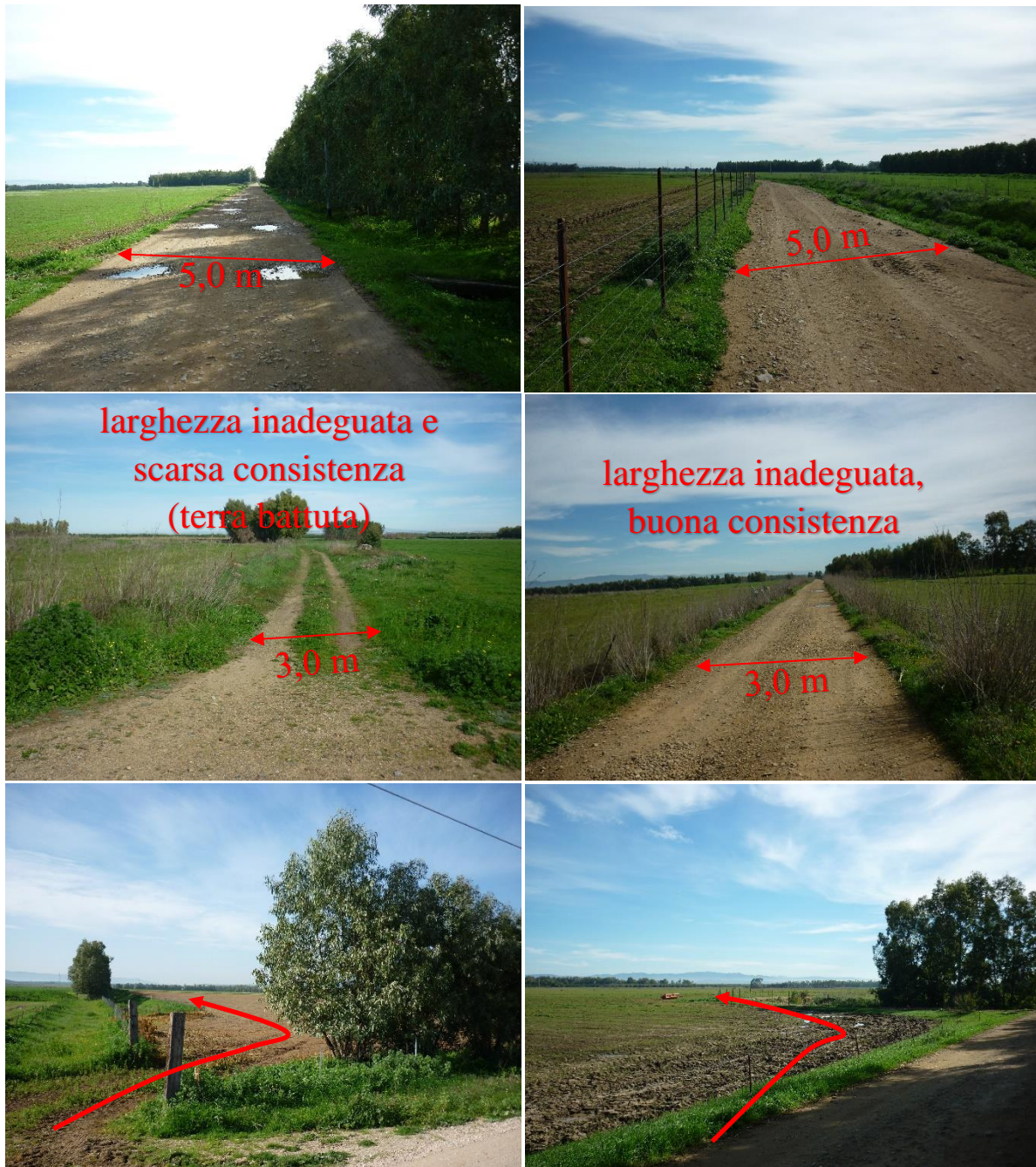
Figura 29 Alcune foto rappresentative della viabilità interna al parco eolico. In alto: viabilità esistente che può essere utilizzata così com'è; al centro: viabilità esistente da adeguare per essere percorsa dai mezzi; in basso: viabilità di nuova realizzazione prevalentemente su battuti/tracce esistenti.
