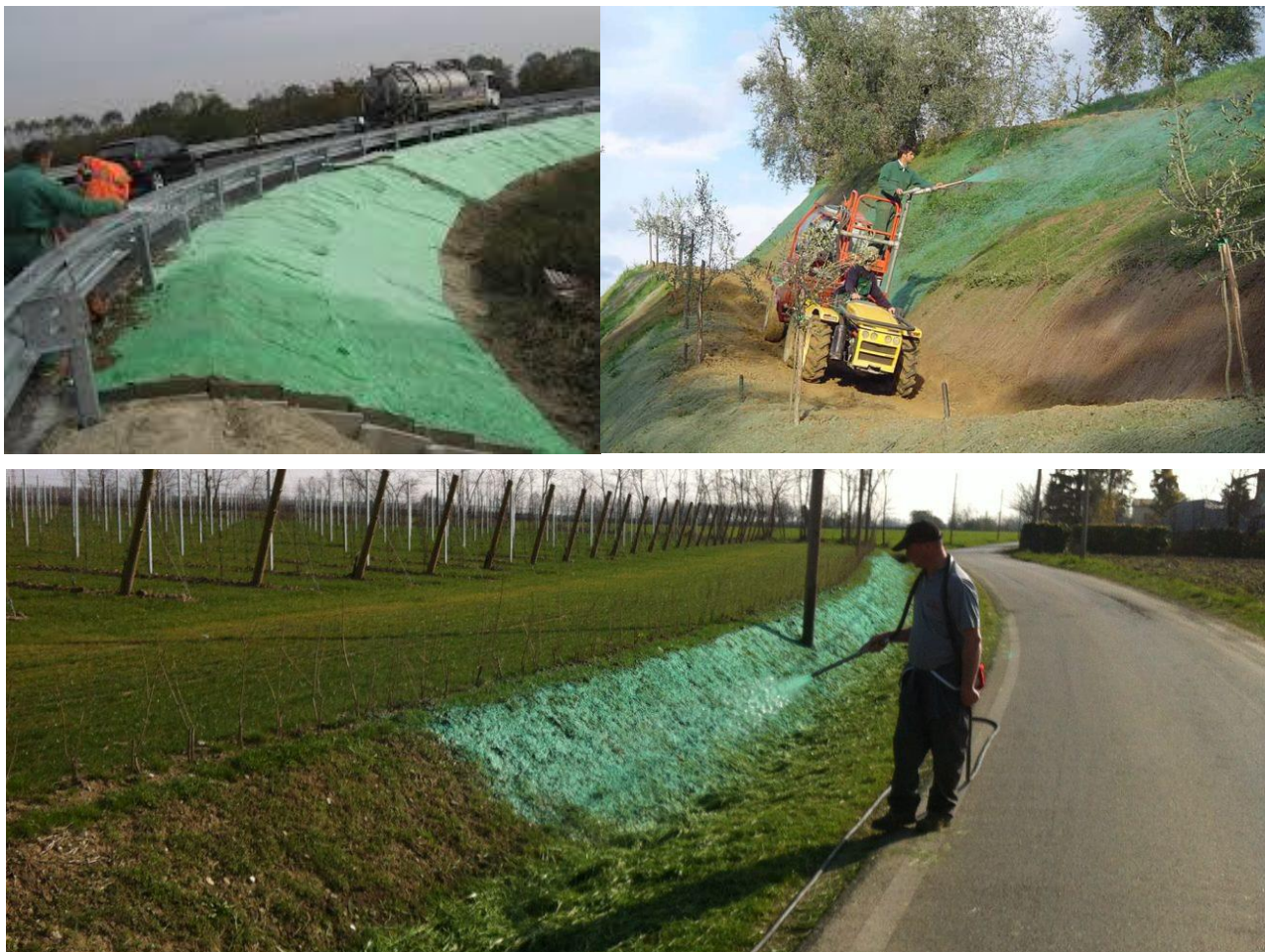
Figura 30: tecniche di idrosemina
