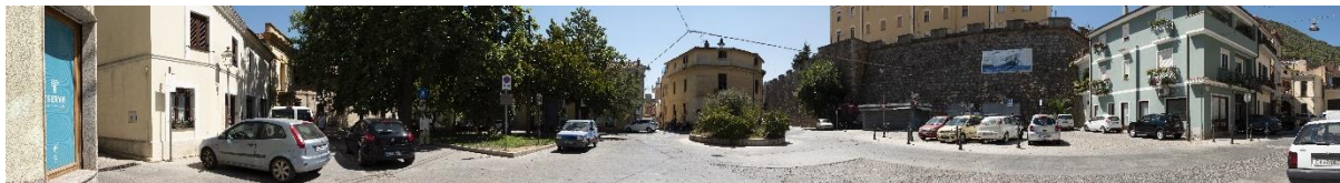
Figura 2: Stato di fatto del F43
