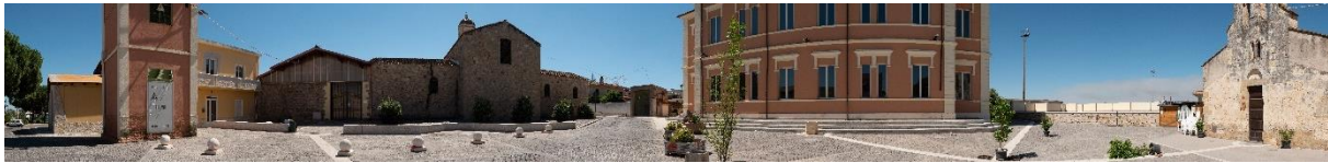
Stato di fatto del F21
