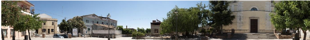
Stato di fatto del F41
