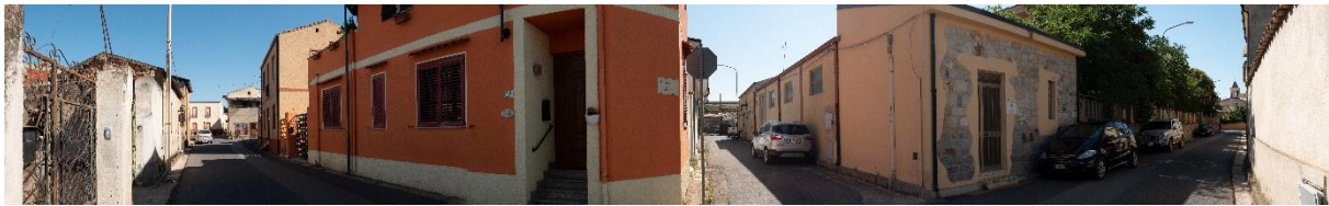
Stato di fatto del F30
