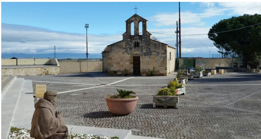
Figura 26 – Chiesa di San Giorgio Martire - Comune di Decimoputzu (CA) – Esterno
