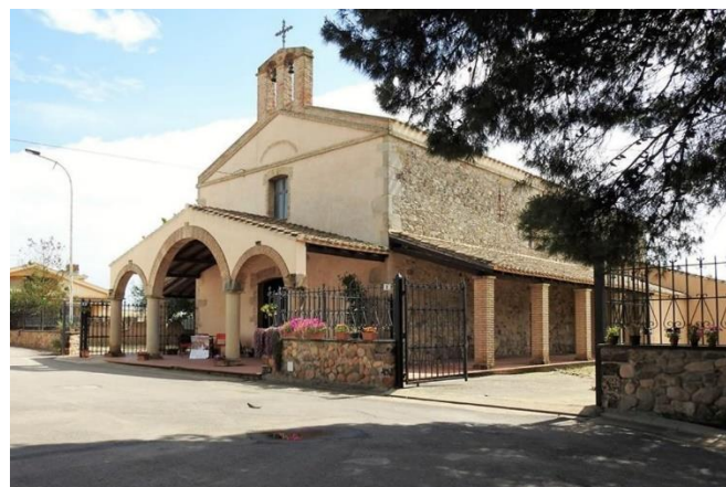
Figura 25 – Chiesa di Santa Vitalia – Villasor (CA) – Esterno
