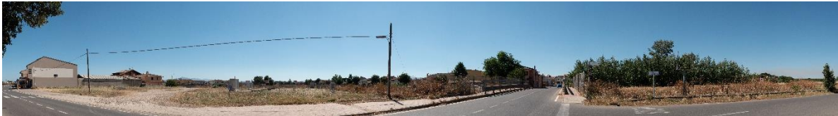
Stato di fatto del F12
