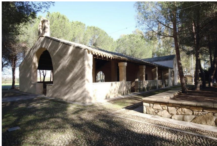
Figura 28 - Chiesa di San Basilio - Comune di Decimoputzu (CA) - Esterno
