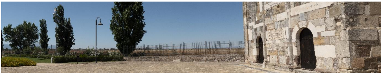
Stato di fatto del F25
