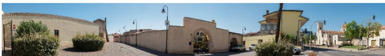
Stato di fatto del F15
