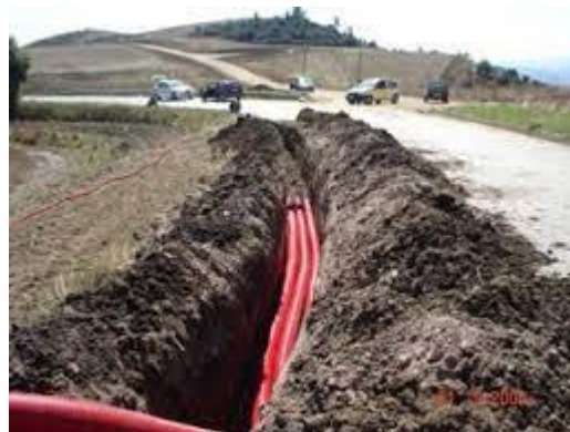
Figura 25 - Posa cavidotto MT tipo
