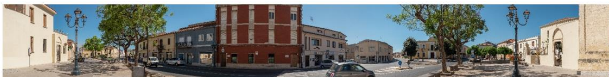
Stato di fatto del F13
