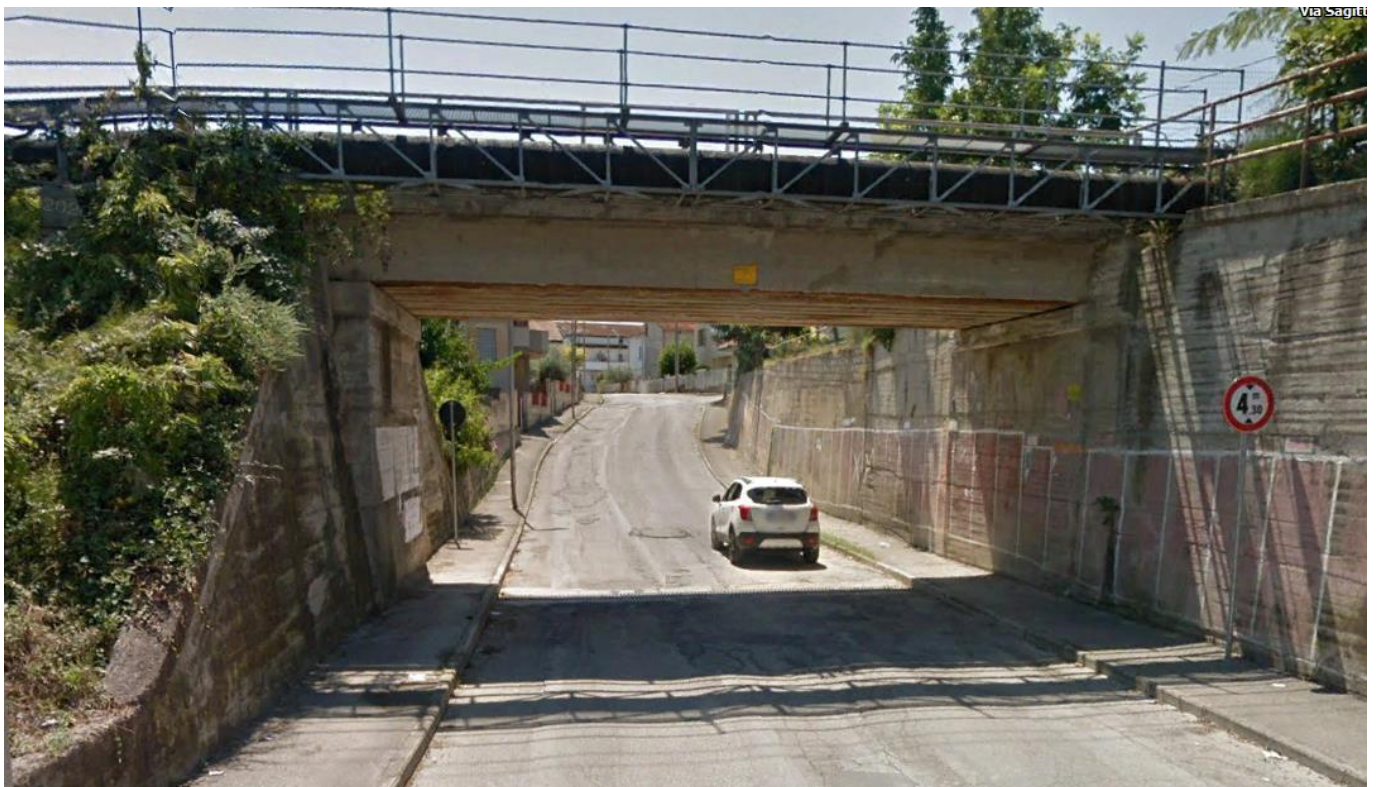
Fig. 2 – VI01 – Ponte esistente su Via Sagittario
