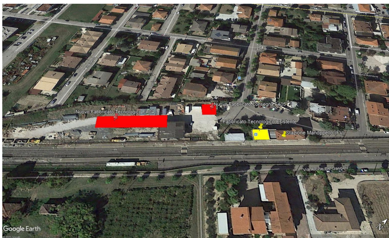
Figura 3 - Stazione Manoppello - Localizzazione fabbricati tecnologici
