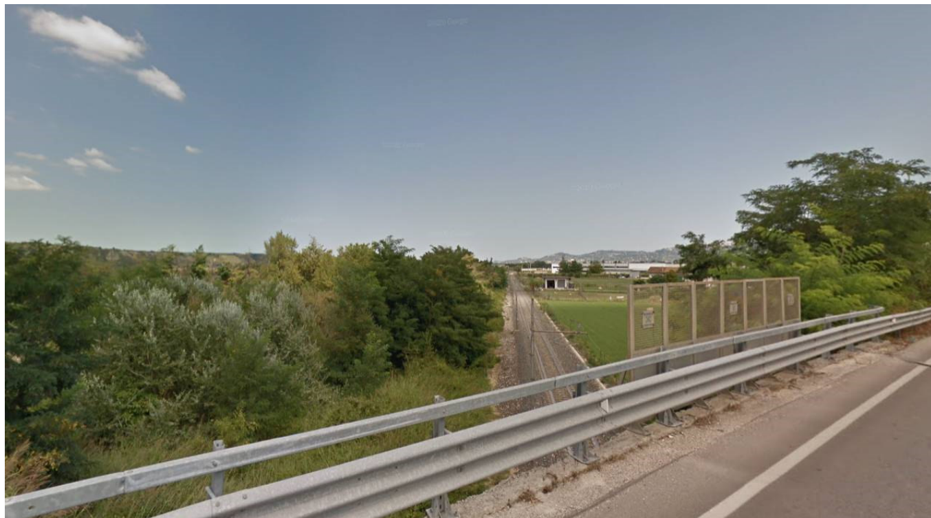
FIGURA 34 SOVRAPPASSO FERROVIARIO LUNGO LA SR 5, ZONA INDUSTRIALE MANOPPELLO, IN DIREZIONE NORD
