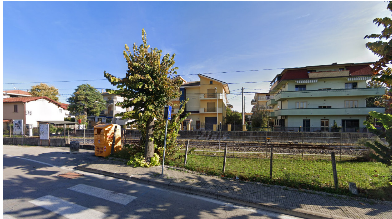
FIGURA 50 FRONTE URBANO LUNGO L'ASSE FERROVIARIO PRESSO VIALE XX SETTEMBRE - MANOPPELLO SCALO
