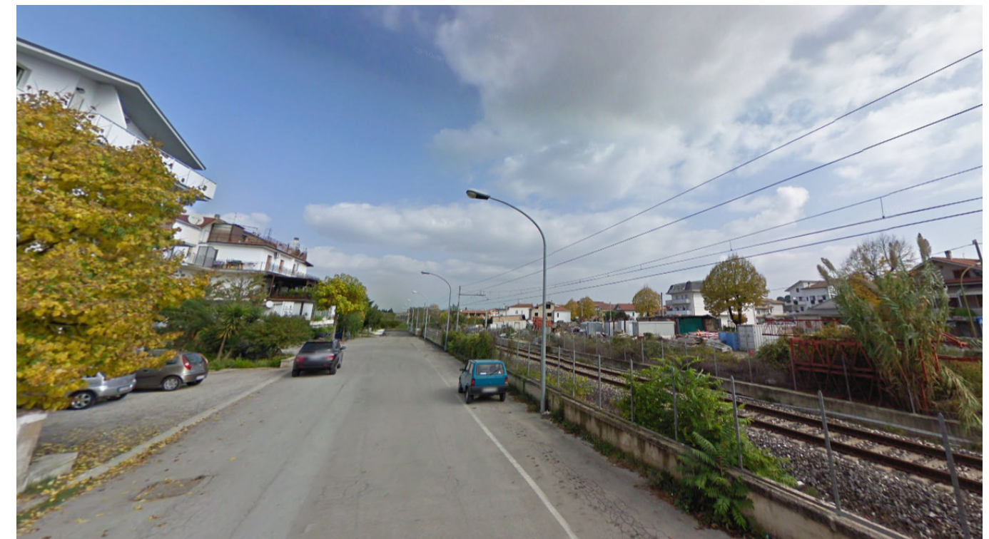
FIGURA 51 FRONTE URBANO LUNGO L'ASSE FERROVIARIO PRESSO VIA GIUSEPPE VERDI - MANOPPELLO SCALO
