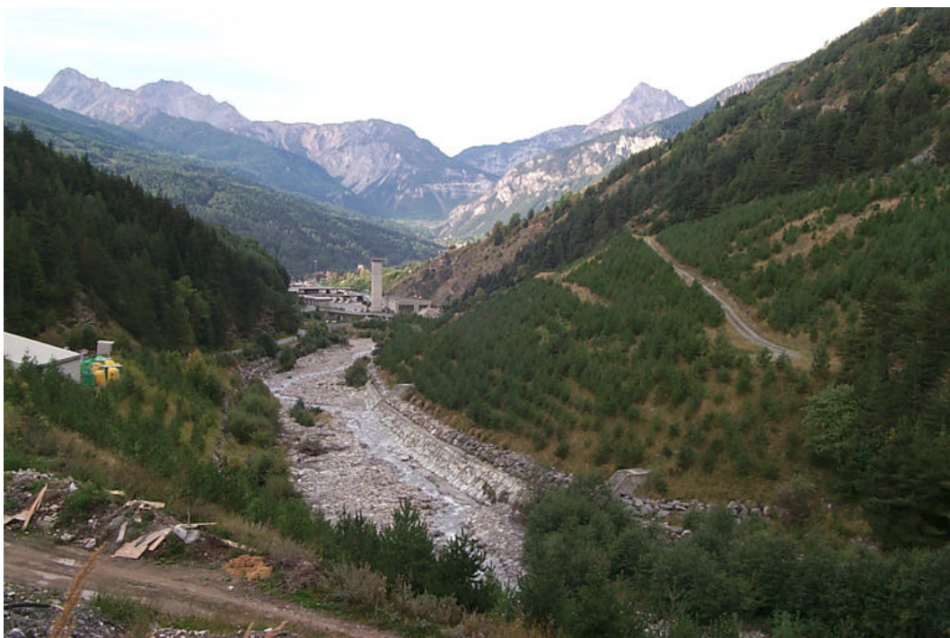
Photo 5.6 – Vue panoramique de haut de la partie terminale du bassin du Torrent Rochemolles: à droite, au premier plan, on voit l'éboulis du remblai du creusement du tunnel routier, au second plan, le secteur de la tête du tunnel routier du Fréjus.
