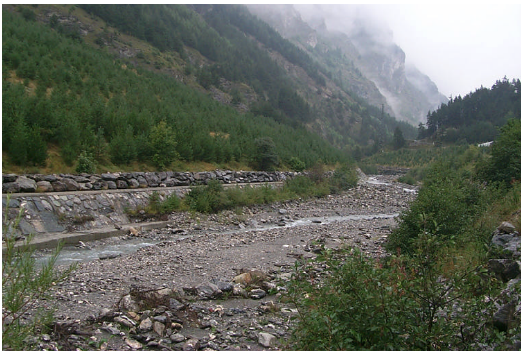
Photo 5.15 - Lit du T. Rochemolles près du dépôt de remblai du creusement du Tunnel routier du Fréjus.
