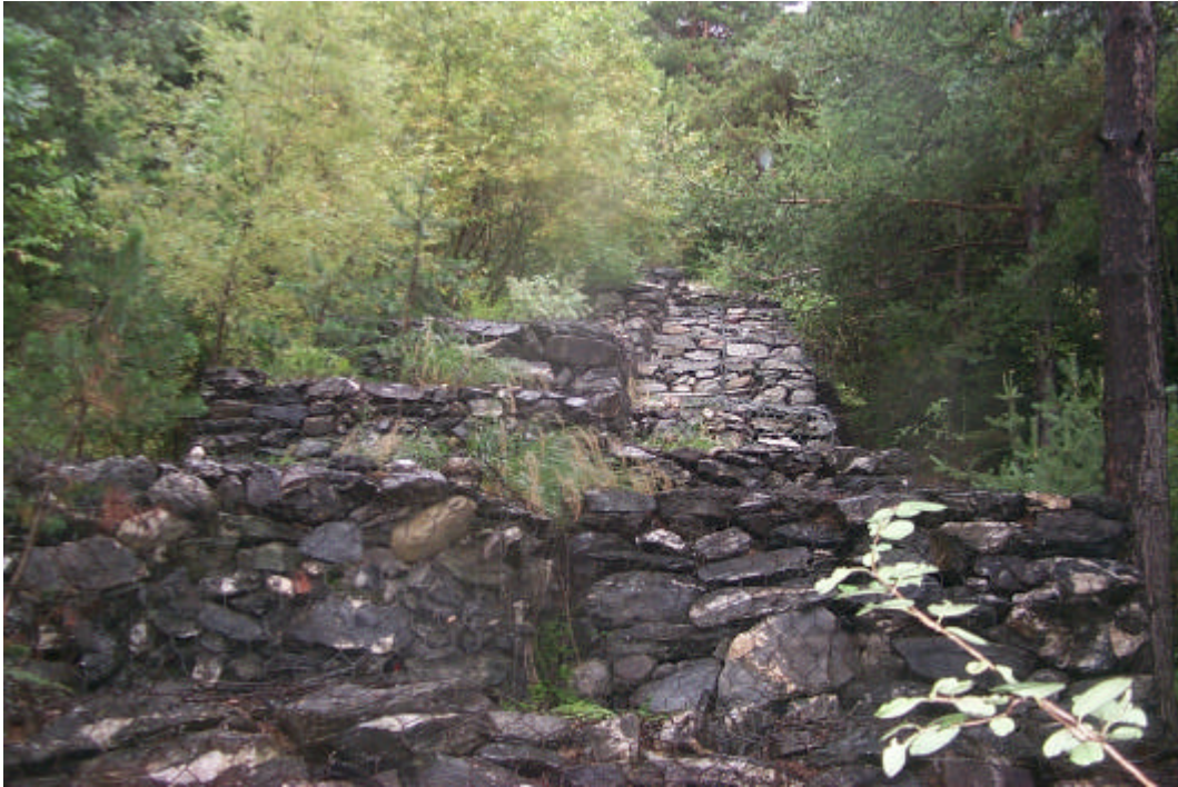
Photo 5.8 – Détail des gabions de protection du flanc gauche du ruisseau éphémère (A sur la Photo 5.7) situé en amont de la tête du Tunnel routier du Fréjus
