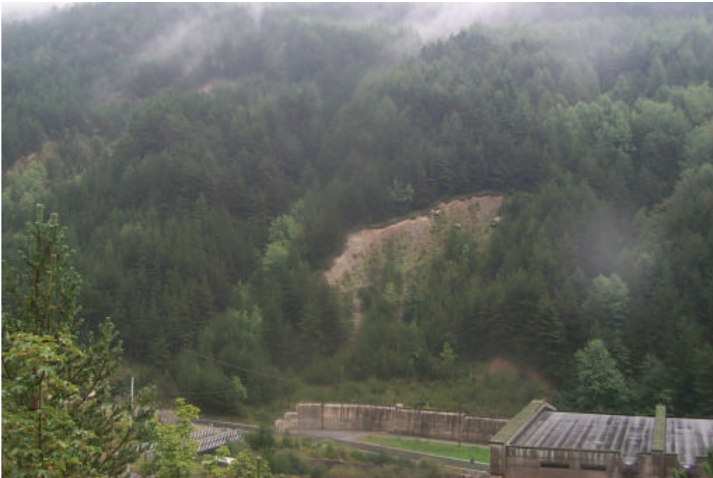
Photo 5.4 – Phénomène de glissement de rotation, avec mur de soutènement à la base (Vallée de Rochemolles, versant gauche).
