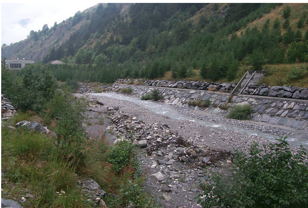
Photo 5.12 - Cordon d'accumulations détritiques alluvionnaire datant de l'événement alluvionnaire d'octobre 2000.
