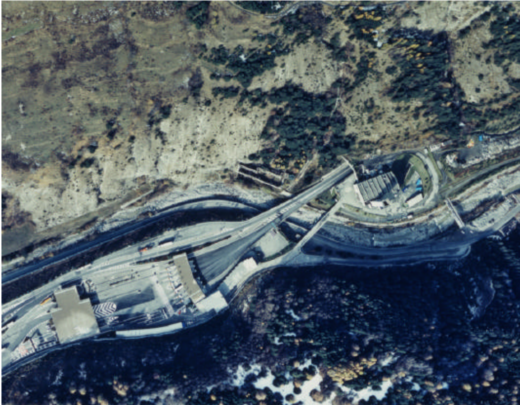
Photo 1.1 – Coupe de photo aérienne du site de tête du tunnel routier du Fréjus.
