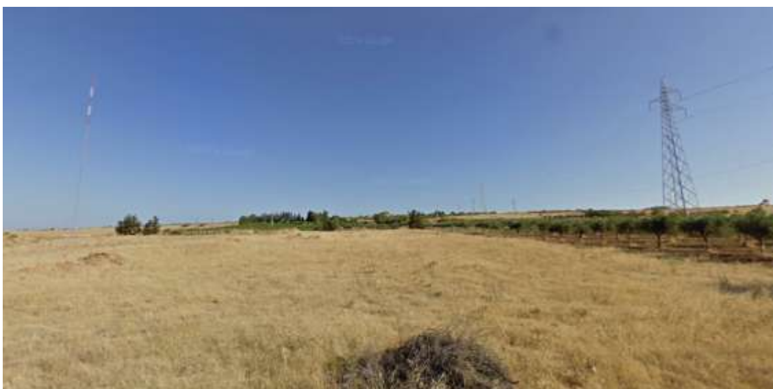
Foto 25-26-27 - Sottostazione di rete
