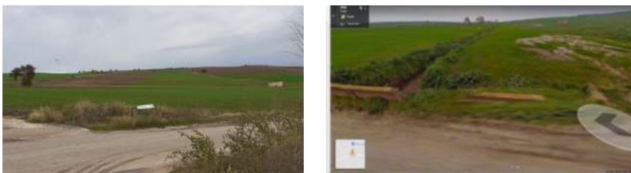
Figura 2.3 – A sx area d'installazione impianto; a dx particolare del canale di scolo oggetto di manutenzione e ripristino.
