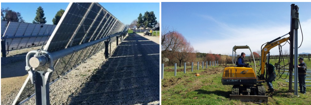
Figura 3 – Esempio di posa delle strutture portanti
