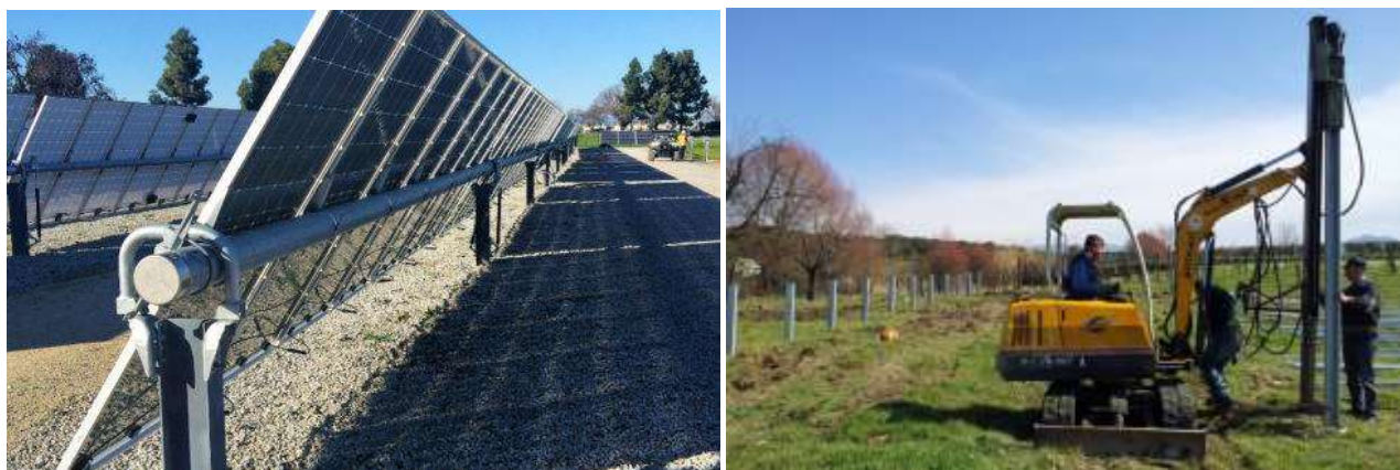
Figura 1 – Esempio di posa delle strutture portanti
