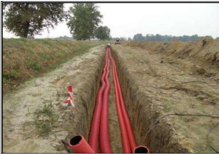
figura n. 7 – Alcune fasi relative per la costruzione dell’impianto
