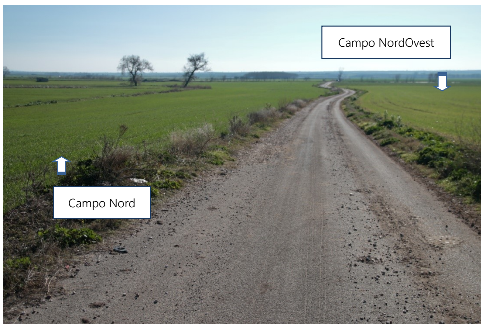
Foto 3 – strada Comunale Tratturo del Re – vista da NO verso S
