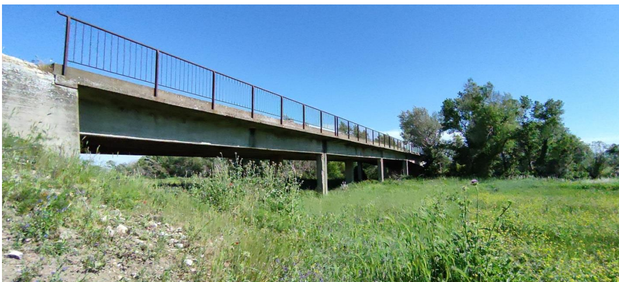
Fig. 22 Foto Ponte sul Fiume Ofanto (Cavidotto AT)
