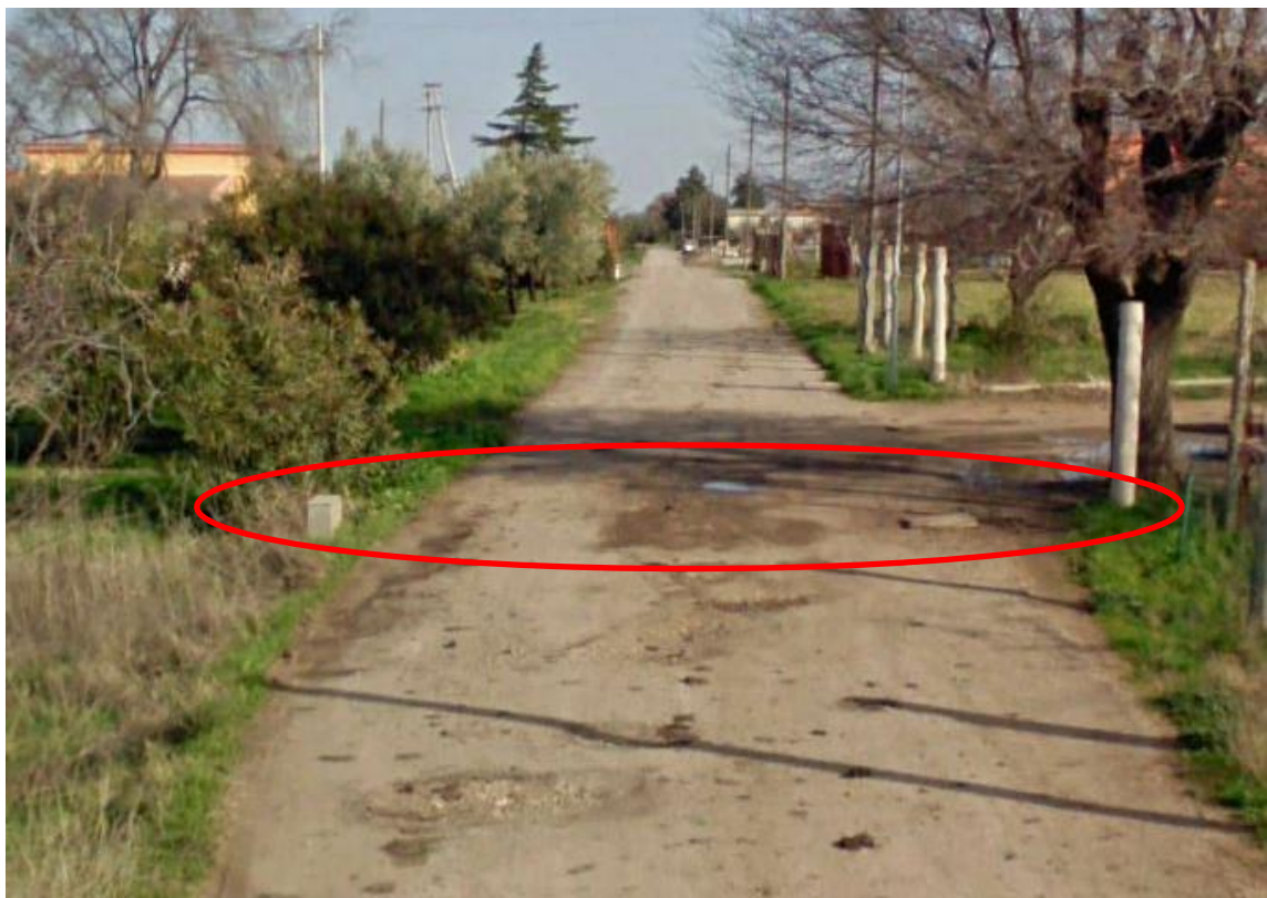
Fig. 34 Foto interferenza condotta idrica n 5
