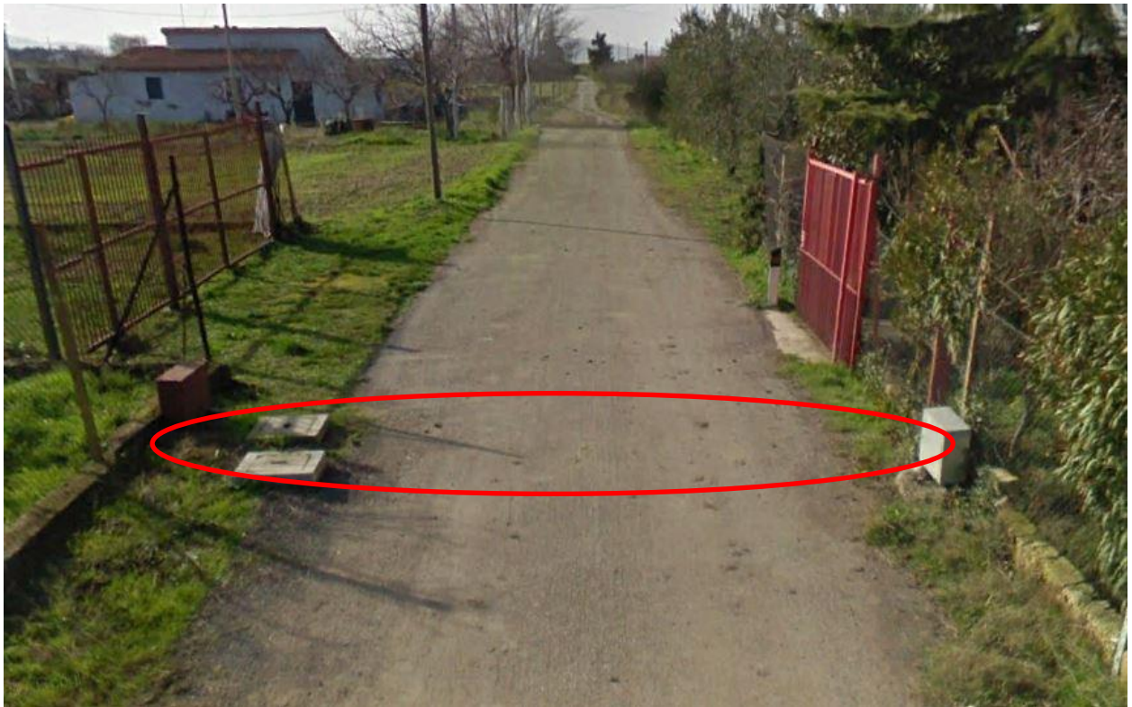
Fig. 33 Foto interferenza condotta idrica n °6
