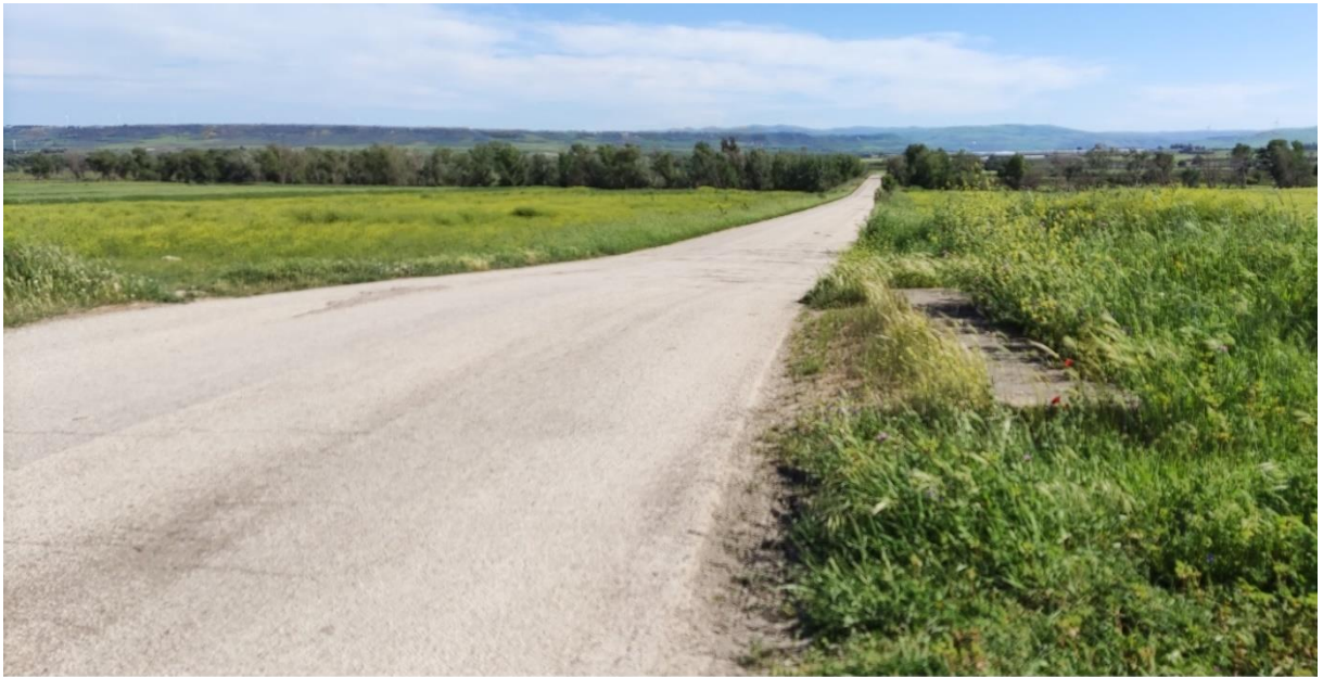
Figura 3-14: S.P. 91 interna all'area protetta (Cavidotto AT)
