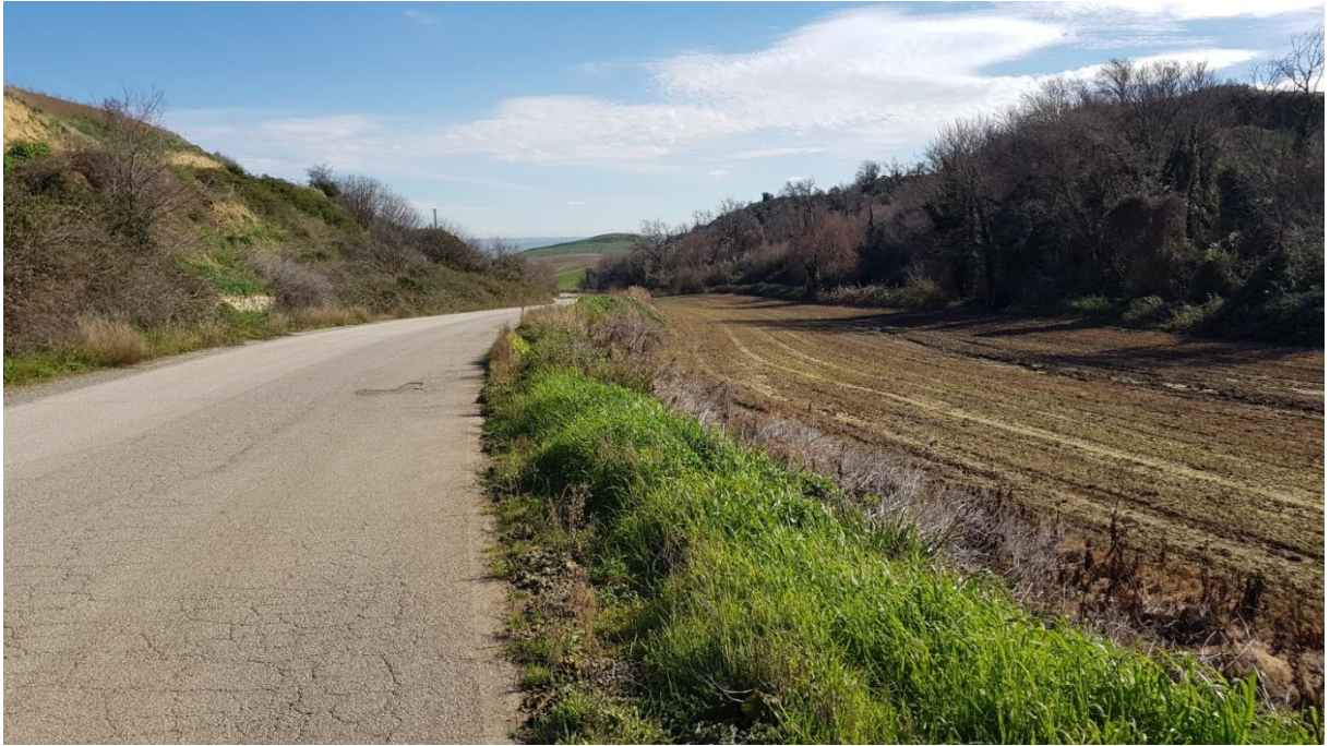
Figura 3-12: S.P. 89 interna all'area protetta (Cavidotto AT)
