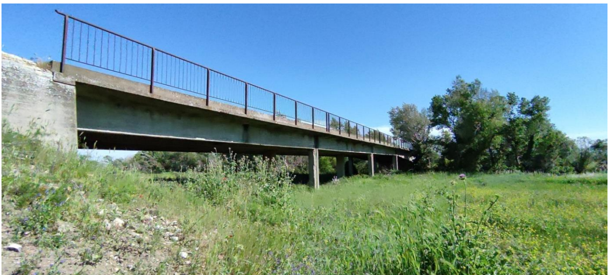
Figura 3-15: Ponte sul Fiume Ofanto (Cavidotto AT)
