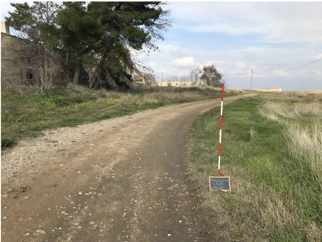
Figura 4-10: Foto strada interpodereale interna all'area protetta (Cavidotto MT)
