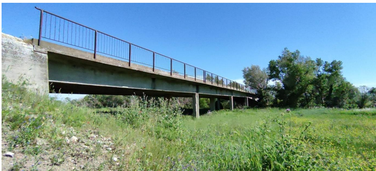
Figura 4-15: Ponte sul Fiume Ofanto (Cavidotto AT)
