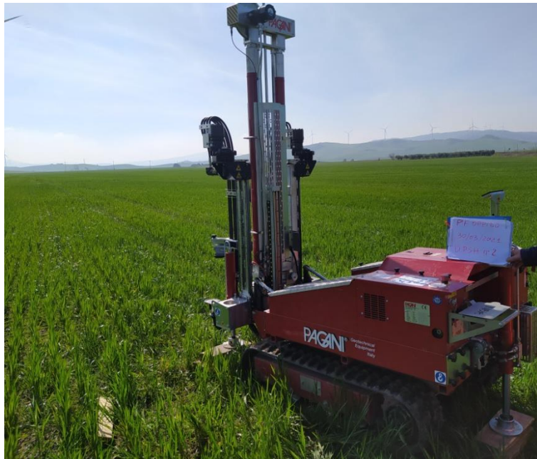
Prova penetrometrica DINAMICA DPSH 02
