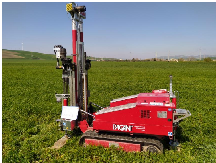
Prova penetrometrica DINAMICA DPSH 03
