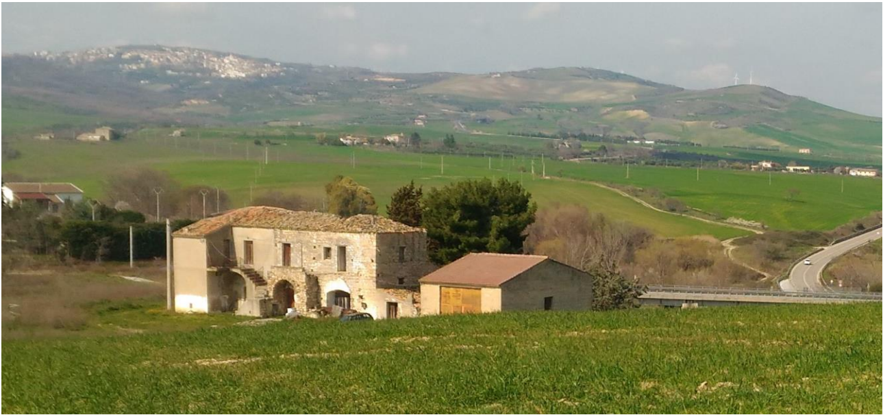
Particolare della Masseria ubicata presso l'area di intervento
