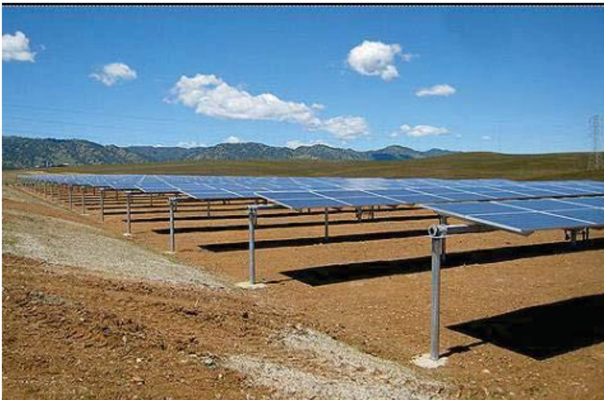
*Figura 6: Rappresentazione della struttura di supporto*
