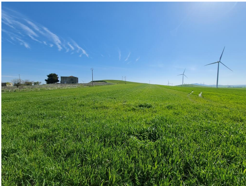
Figura 5-4 panoramica area impianto Piano Gorgo
