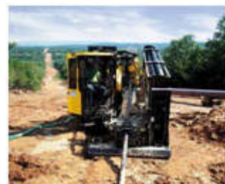
PERFORAZIONI MEDIANTE LA NO-DIG
