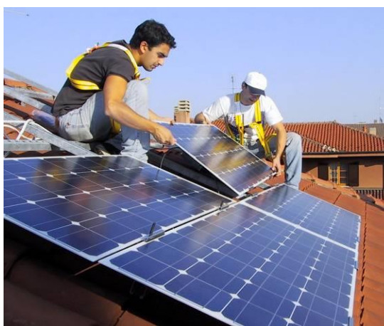
Figura 5: Operai montatori di pannelli fotovoltaici su solai di copertura
