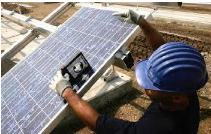
Figura 6 Operai montatori di pannelli fotovoltaici su suolo
