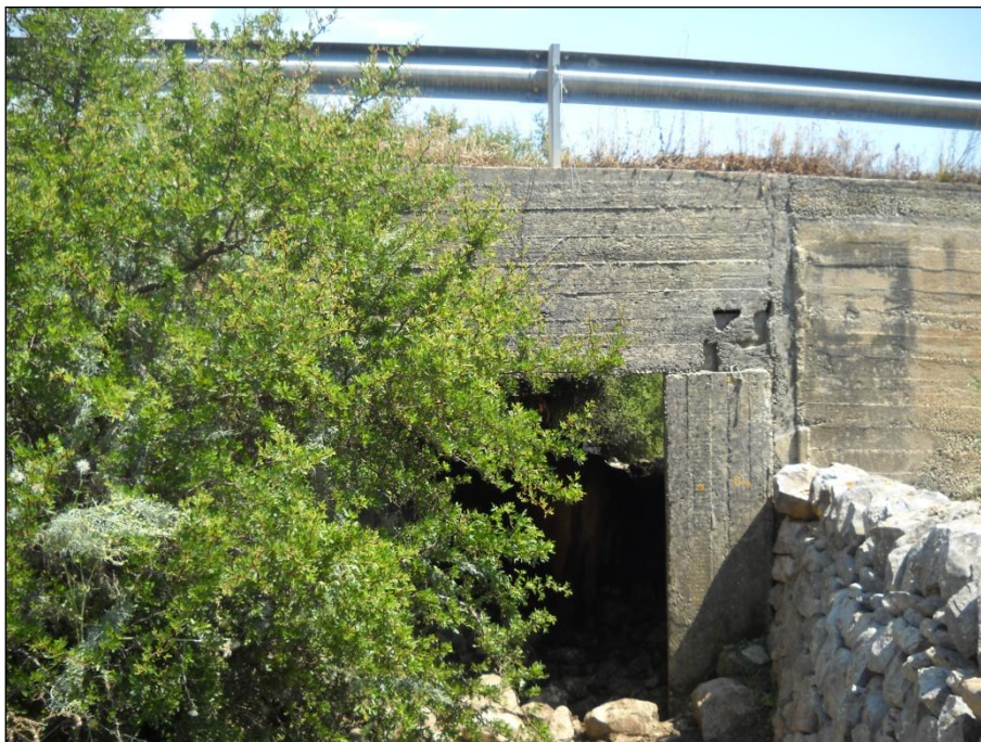
Figura 11-7: ponticello sulla S.R. 63
