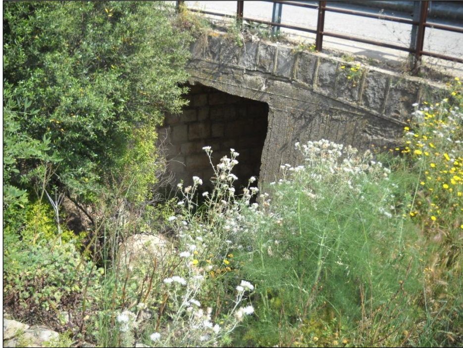
Figura 11-6: ponticello al km 10 della S.P: 81
