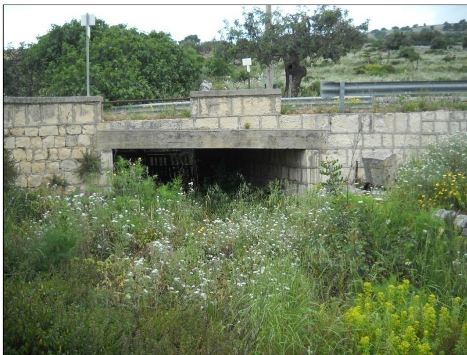
Figura 11-5: ponticello al km 7 della S.P: 81
