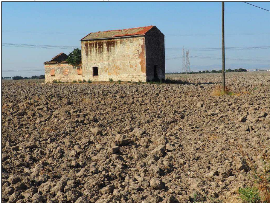
Foto 9.1 – vista sud ovest
