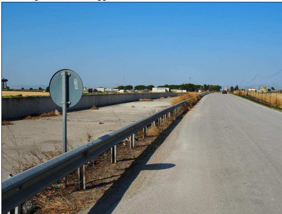
Foto 2.1 – vista sud ovest
