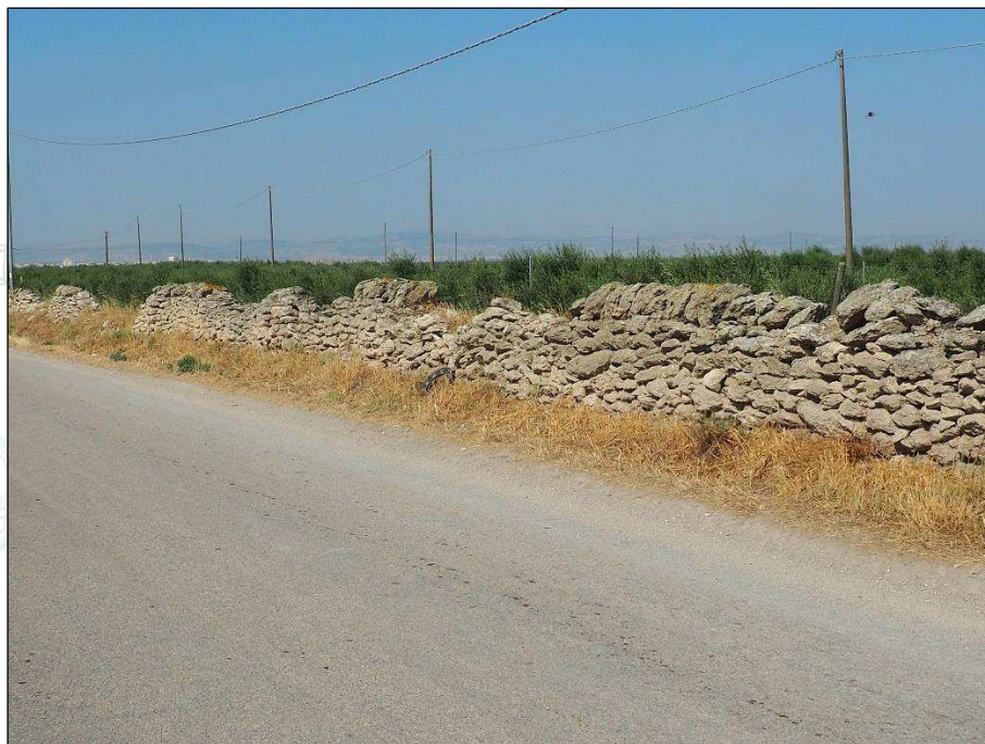
Foto 1.1-Muretto a secco su terreno al Foglio 72 p.lla 238 fronte strada "Tratturo Castiglione"
