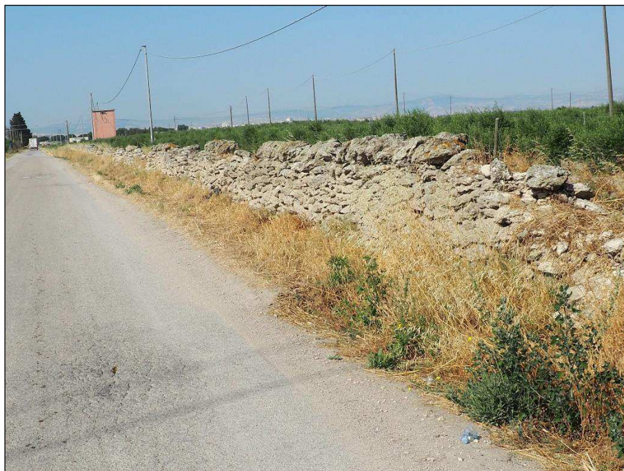
Foto 1.2-Muretto a secco su terreno al Foglio 72 p.lla 238 fronte strada "Tratturo Castiglione"
