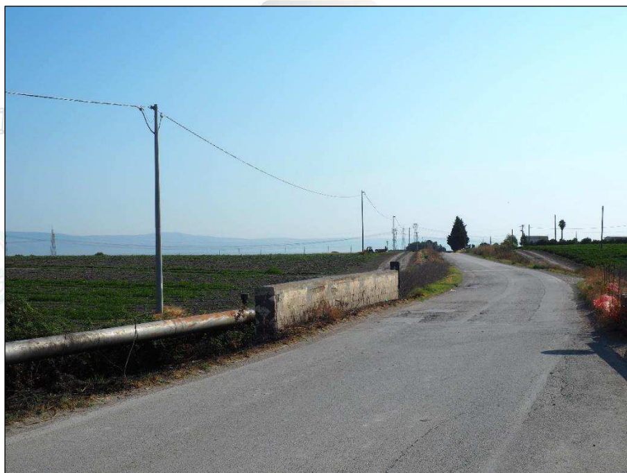
Foto 3.2 – vista sud ovest
