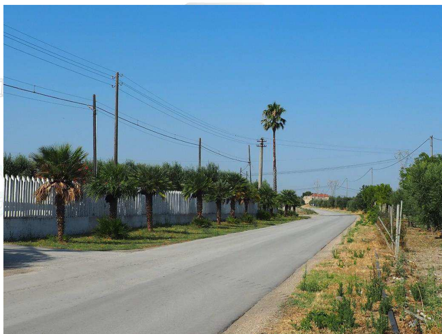
Foto 10.2 – vista sud ovest
