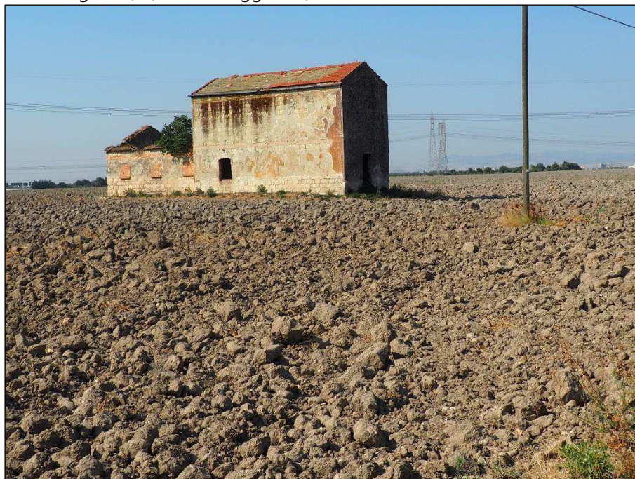
Foto 9.1 – vista sud ovest
