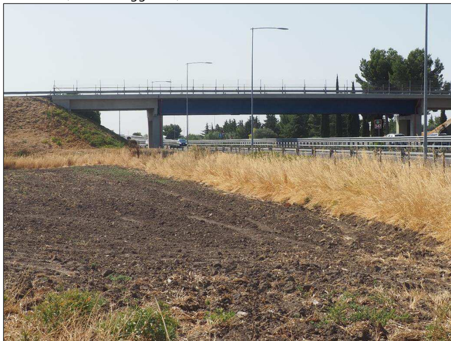
Foto 18.1 – vista nord ovest
