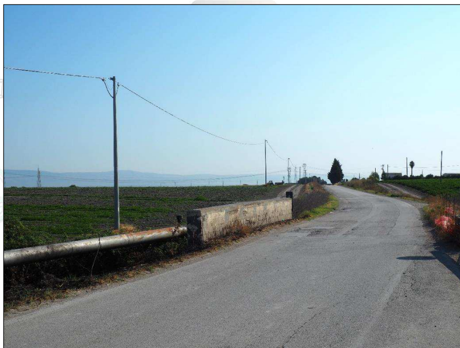
Foto 3.2 – vista sud ovest
