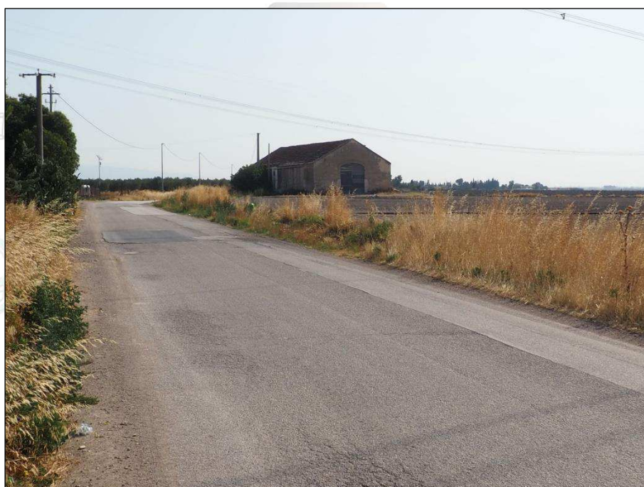
Foto 7.2 – vista nord est
