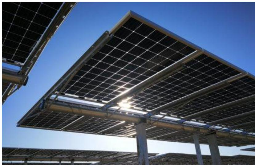
Figura 3.5 Esempio di struttura a tracker monoassiale
