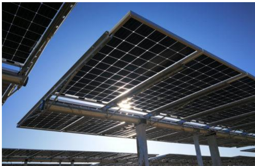
Figura 4.5 Esempio di struttura a tracker monoassiale
