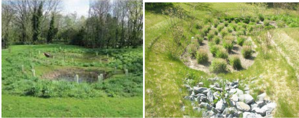
Figura 4.10 Immagini esemplificative di bacini di infiltrazione
