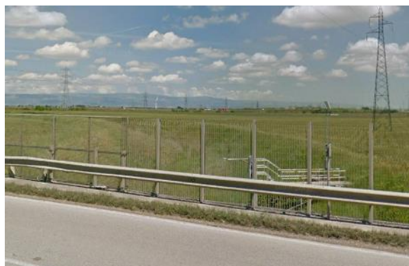
Figura 5-50: Stato di fatto – vista verso monte
