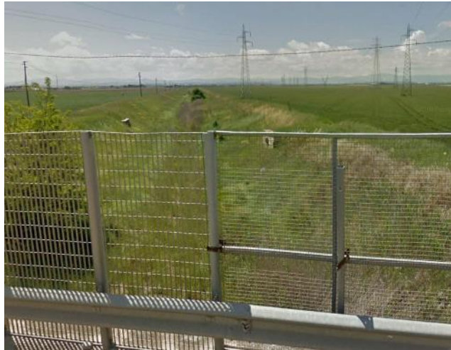
Figura 5-51: Stato di fatto – vista verso valle
