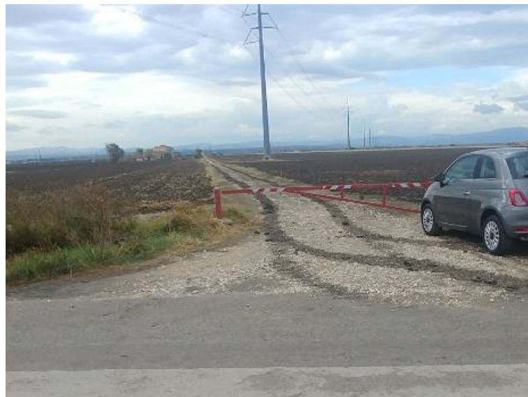
Figura 5-24: Stato di fatto –Fotografia
