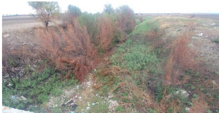
Figura 5-18: Stato di fatto –Fotografia
