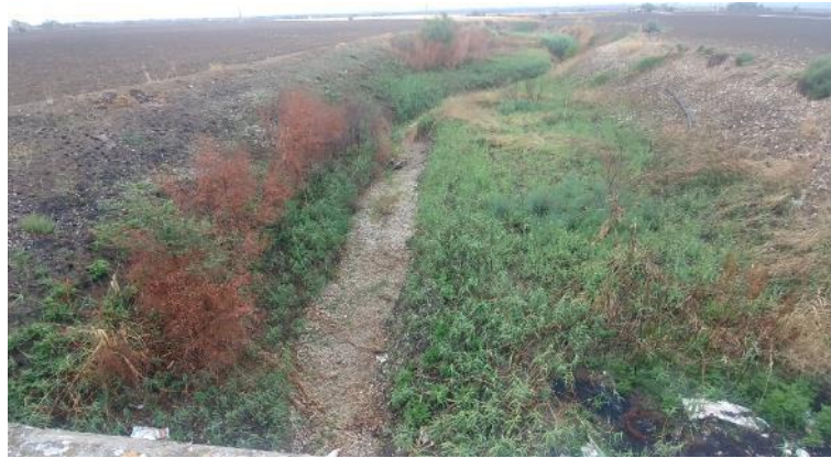
Figura 5-17: Stato di fatto –Fotografia
