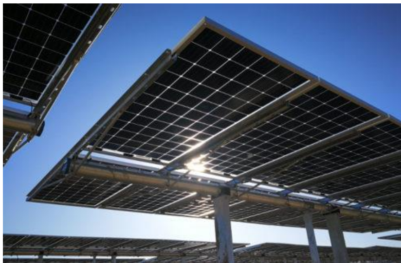
Figura 3.2: Esempio di struttura a tracker monoassiale
