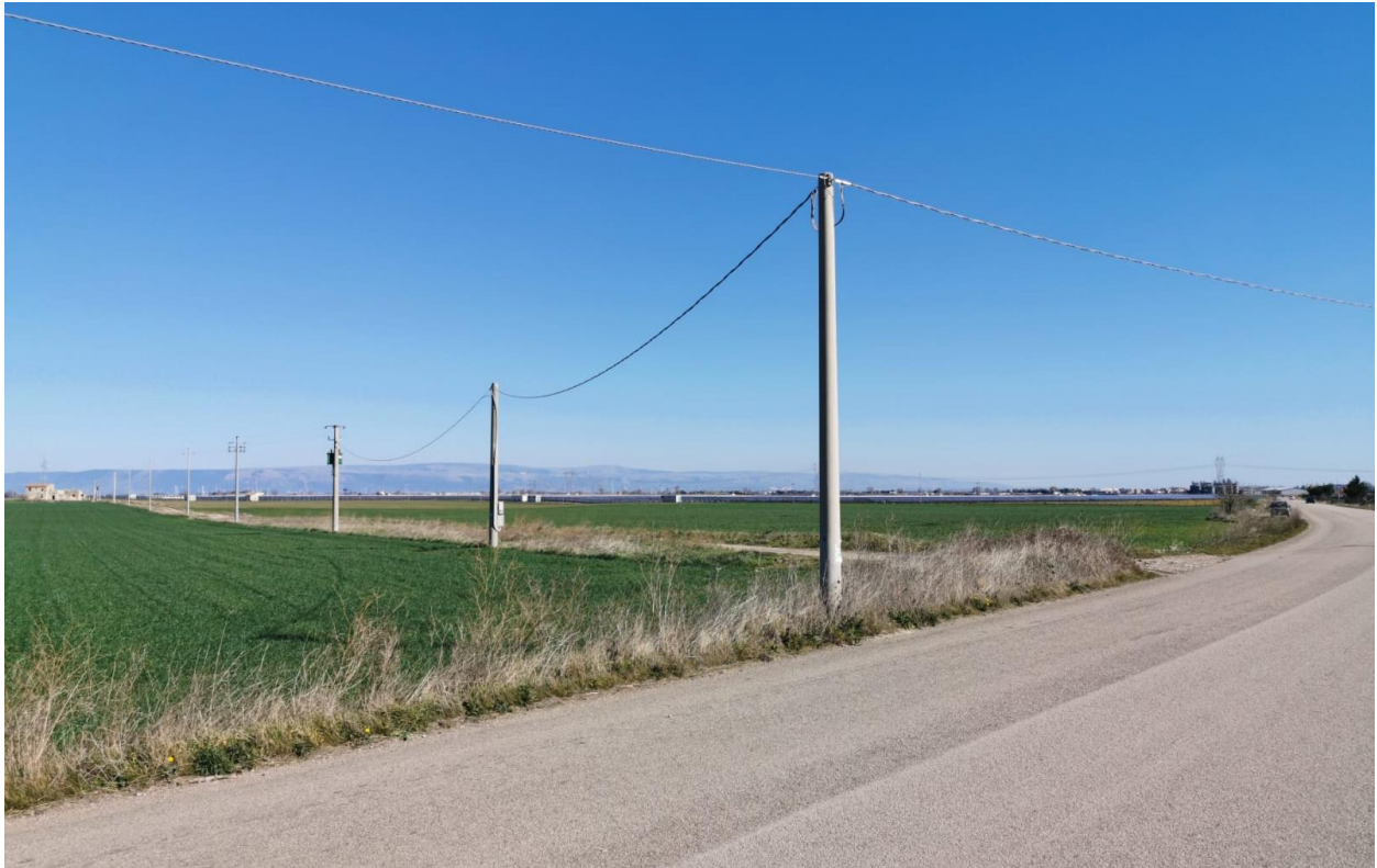
Figura 5.6 Fotoinserimento 2 – Stato du Fatto– Strada Vicinale Vado Biccari – Impianto esistente ad est
