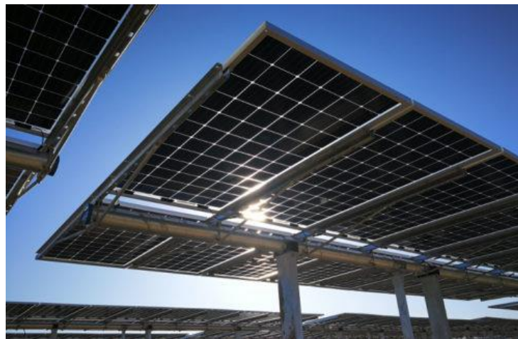
Figura 2.6: Esempio di struttura tipo tracker monoassiale
