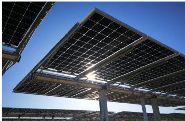
*Figura 2.6: Esempio di struttura tipo tracker monoassiale*
